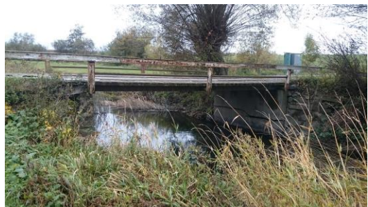
Figur 16 Vägbro vid Knästorp. Foto: Siri Wahlström
