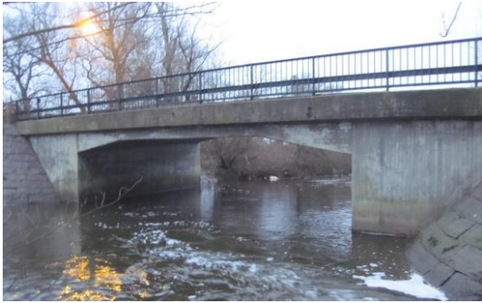
Figur 9 Bron under Värpinge bygata/ Trollebergsvägen. Foto: (Trafikverket, 2016)
