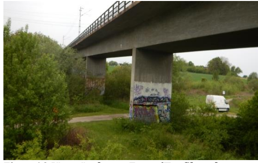
Figur 10 Järnvägsbron. Foto: (Trafikverket, 2016)
