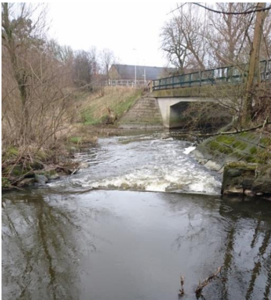
Figur 1 Dämnet uppströms Trollebergsvägen. Foto: Siri Wahlström
