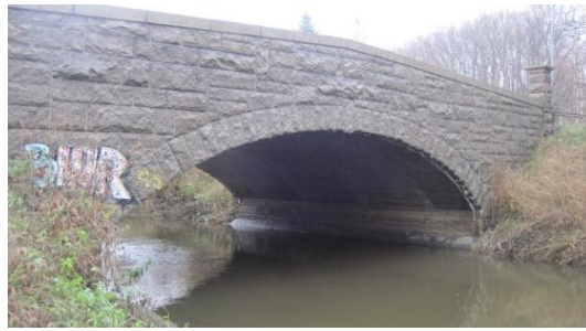
Figur 14 Bron under Malmövägen. Foto: (Trafikverket, 2016)
