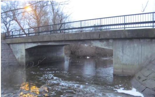
Figur 9 Bron under Värpinge bygata/ Trollebergsvägen. Foto: (Trafikverket, 2016)
