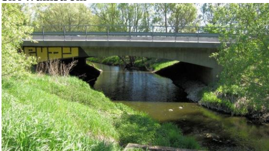
Figur 15 En av broarna under väg E22. Foto: (Trafikverket, 2016)
