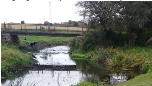
Figur 11 Bron under Flackarps byväg. Foto: Siri Wahlström
