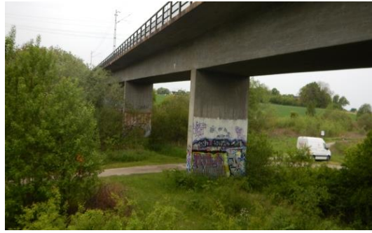
Figur 10 Järnvägsbron. Foto: (Trafikverket, 2016)
