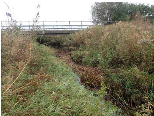
Lokalens nedre del, vy uppströms (igenväxt)
