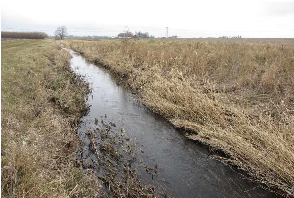
Figur 71. Råbydike vid mynningen i Höje å. Rakt dike utan någon beskuggning.
