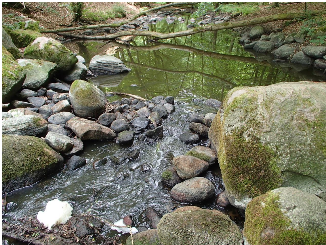
Figur 47. Höje å nedströms Häckebergasjön. Dämnet vid inloppet till kvarnrännan uppströms Genarp.
