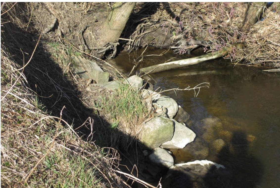
Figur 23. Höje å nedströms Alberta. Stenar har placerats i slänten för att förhindra fortsatt erosion på vissa platser.
