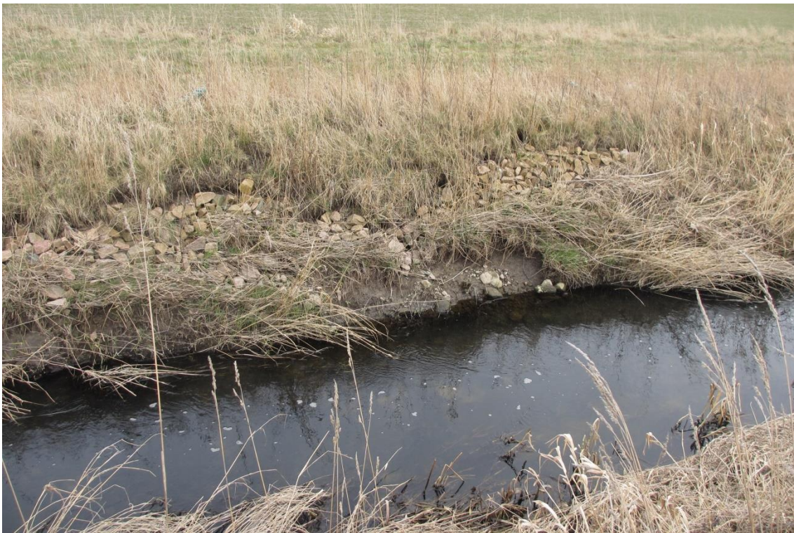
Figur 56. Vallkärrabäcken vid Lilleby. Stenkross har lagts i slänten för att motverka fortsatt erosion.
