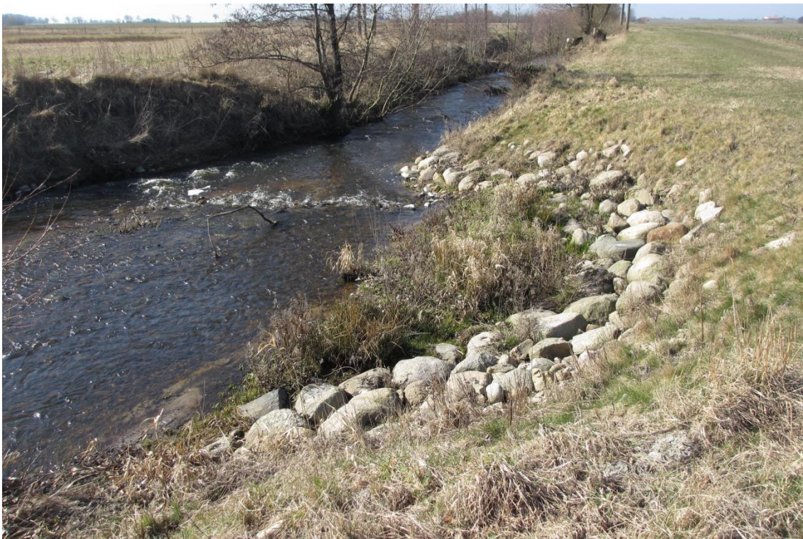
Figur 35. Höje å nedströms Gödelövsbäckens mynning. Erosionsskydd i slänten.
