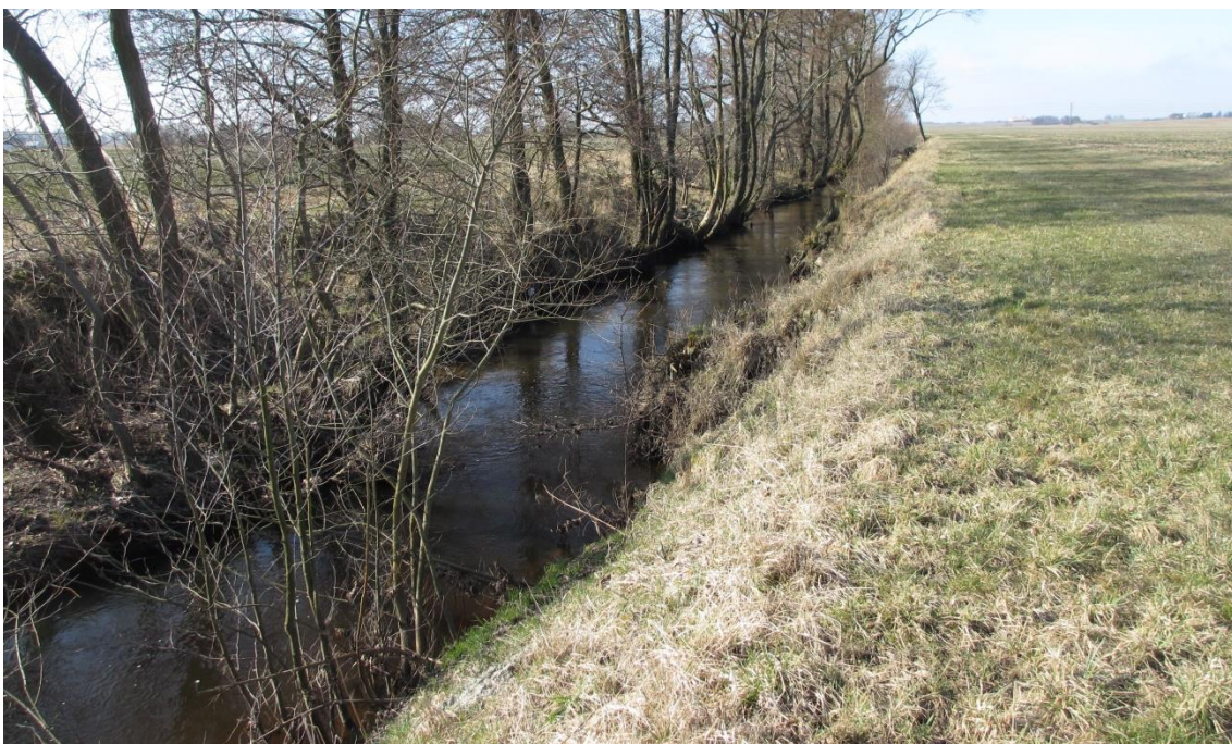
Figur 36. Höje å nedströms Gödelövsbäckens mynning. Träd längs åns södra slänt. Bidrar dels till beskuggning men stabiliserar även slänten och minskar risken för erosion.
