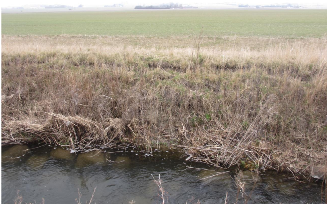
Figur 75. Råbydiket vid stora Bjällerup. Branta slänter med erosion. Stora stenar/block har lagts i diket troligen för att minska erosionen vid kulvertens mynning.
