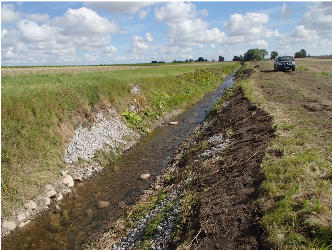
Figur 49. Vallkärrabäcken vid Vindfälle gård. Slänten har avfasats till höger i fotot och till vänster har sten lagts i slänten för att motverka fortsatt erosion. Avfasningen är nyligen genomförd vid tillfället för fotograferingen. Fotograf: Håkan Björklund, Ekologgruppen
