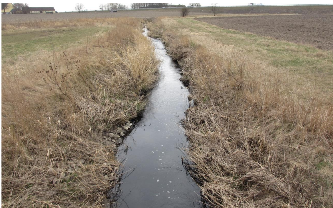
Figur 42. Vallkärrabäcken vid Lilleby. Sträckan är rak och har troligen rätats vid något tillfälle.
