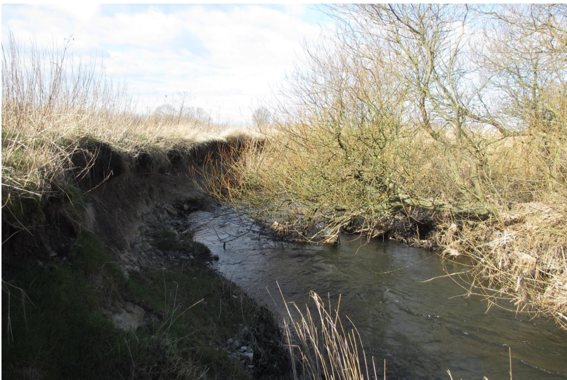
Figur 6. Höje å nedströms den återmeandrade sträckan vid Trolleberg. Erosion av slänt påträffades i nästan varje sväng.
