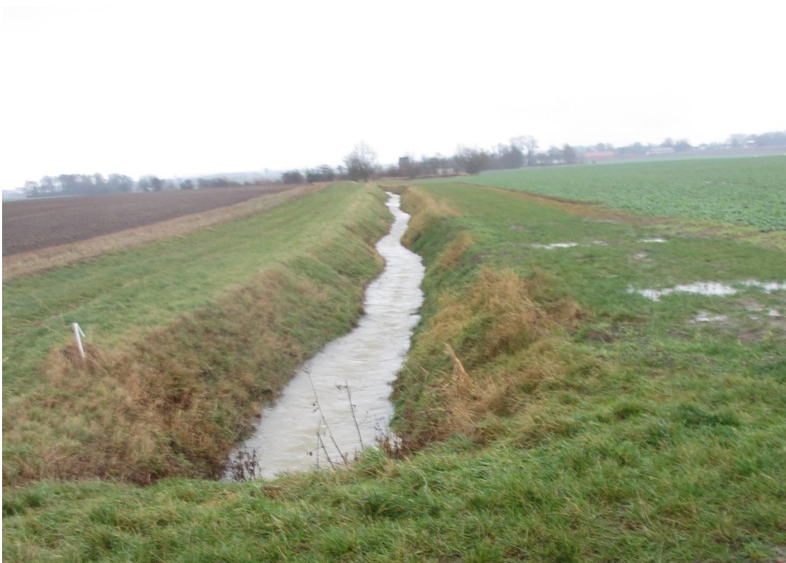
Figur 78. Dalbydiket nedströms damm på fastighet Dalby 2:5. Uppströms vägen syns inga tecken på erosion här är även slänterna något flackare.
