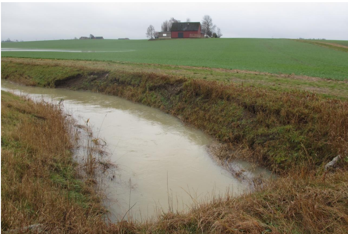
Figur 74. Dalbydiket söder om damm på fastighet Dalby 21:27. Erosion av den södra slänten i Dalbydiket.
