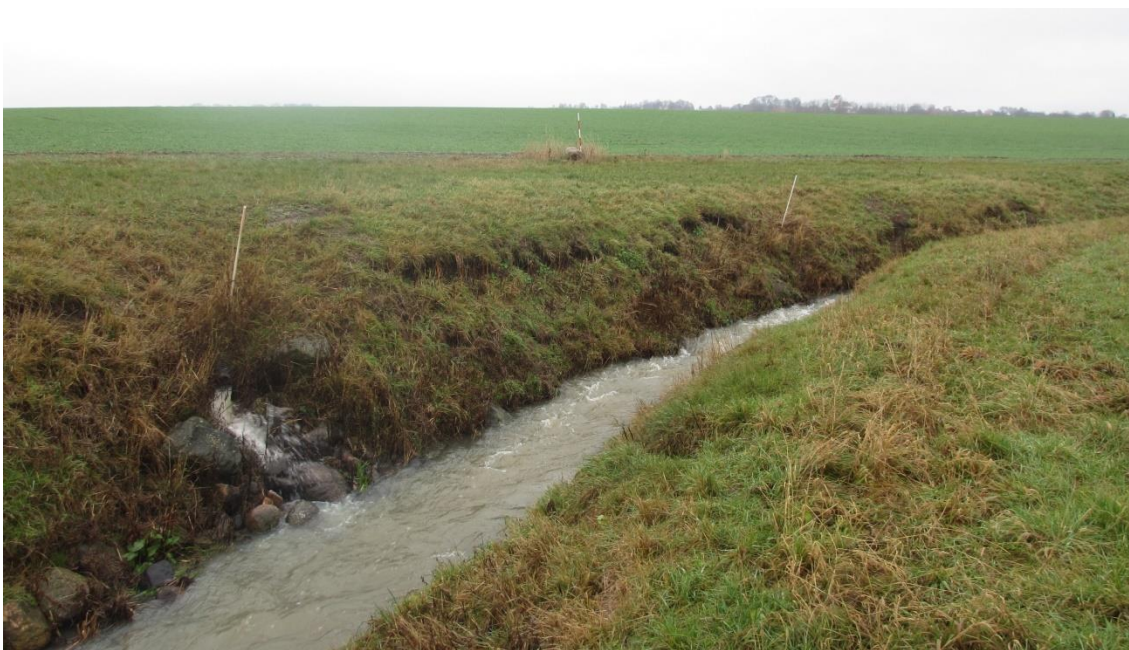
Figur 71. Dalbydiket uppströms reningsverket. Ytterligare erosion på de nedre delarna av den karterade sträckan. I det högra hörnet av fotot ligger stenar i slänten vilket kan vara ett försök att minska erosionen i diket.
