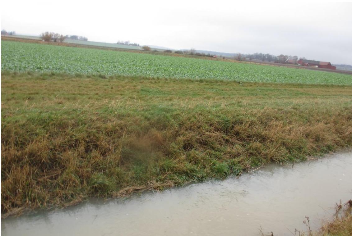
Figur 77. Dalbydiket nedströms damm på fastighet Dalby 2:5. Lite erosion i slänt.
