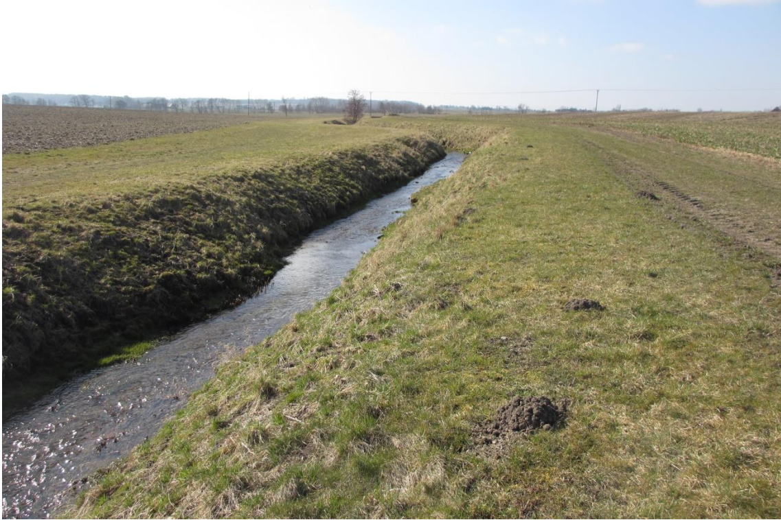
Figur 80. Gödelövsbäcken nedströms Gödelöv. Bäcken är djupt nedskuren och har relativt flacka och gräsbeväxta slänter.
