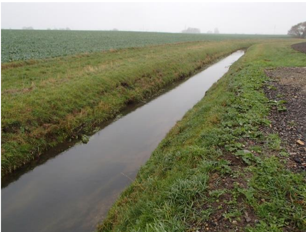
Figur 41. Vallkärrabäcken uppströms Fjelle. Erosion av slänt i de övre delarna av sträckan, uppströms Fjelle Boställe.
