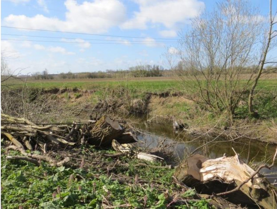
Figur 18. Höje å vid Lilla Bjällerup. Erosionsproblem på slänten.
