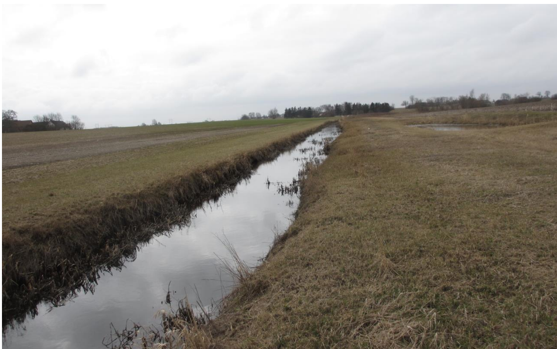
Figur 59. Dynnbäcken nedströms Vesumsvägen. Bäckan är rak och kantas av branta slänter
