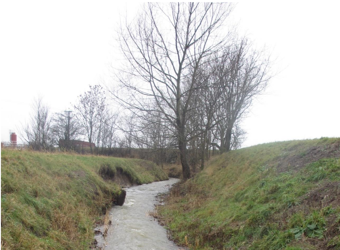
Figur 70. Dalbydiket uppströms reningsverket. Kraftig erosion i de nedre delarna av den karterade sträckan.
