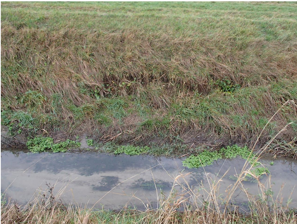
Figur 67. Dalbydiket nedströms reningsverket. Erosion av slänt i Dalbydiket i de nedre delarna av karterad sträcka.
