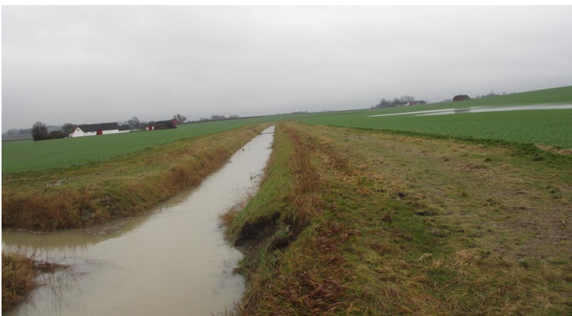
Figur 75. Dalbydiket söder om damm på fastighet Dalby 21:27. Översvämning på åkern söder om diket.
