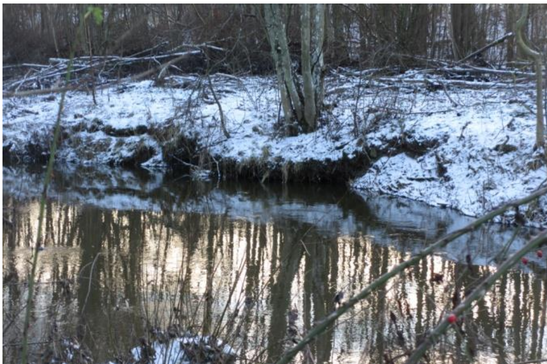
Figur 8. Höje å vid St Lars. Erosion längs Höje å. Trädet står på ett överhäng som riskerar att rasa ner i ån.
