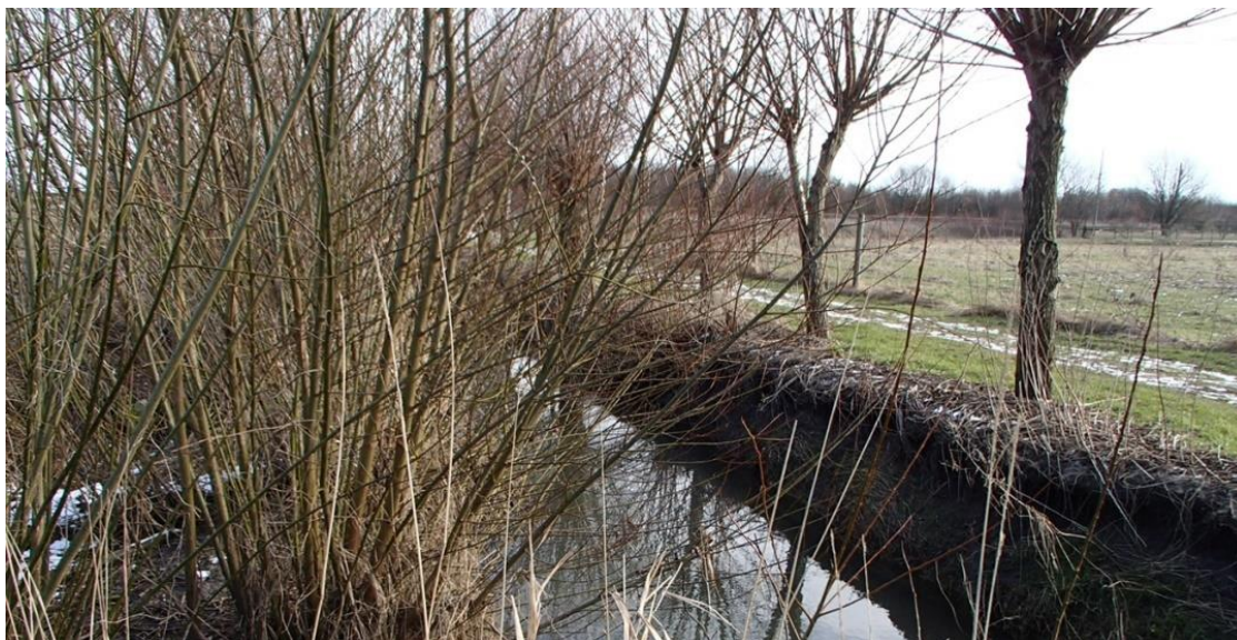
Figur 44. Vallkärrabäcken nedströms järnvägen. Erosion av slänterna på södra sidan av bäcken.
