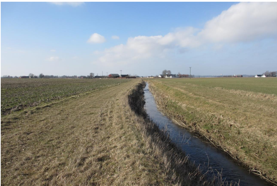
Figur 65. Dalbydiket vid Vallby. Ett rakt dike med relativt flacka slänter.
