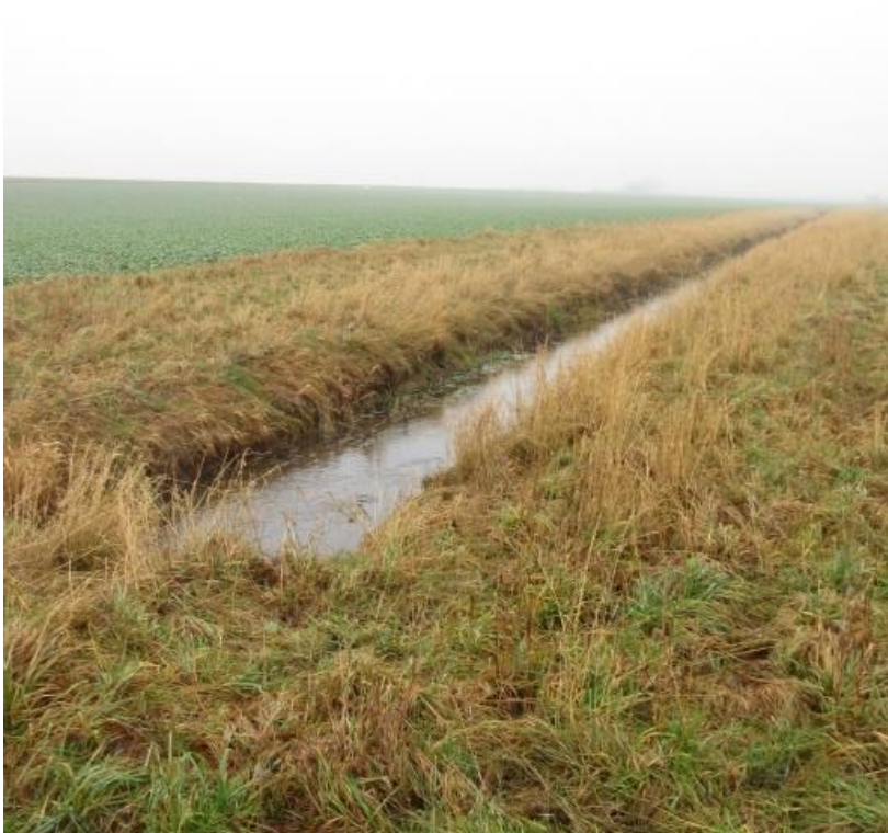
Figur 55. Dike nedströms Fels mosse. Ett rakt dike där tvåstegsdike hade kunnat vara en lämplig åtgärd för att minska erosionen.
