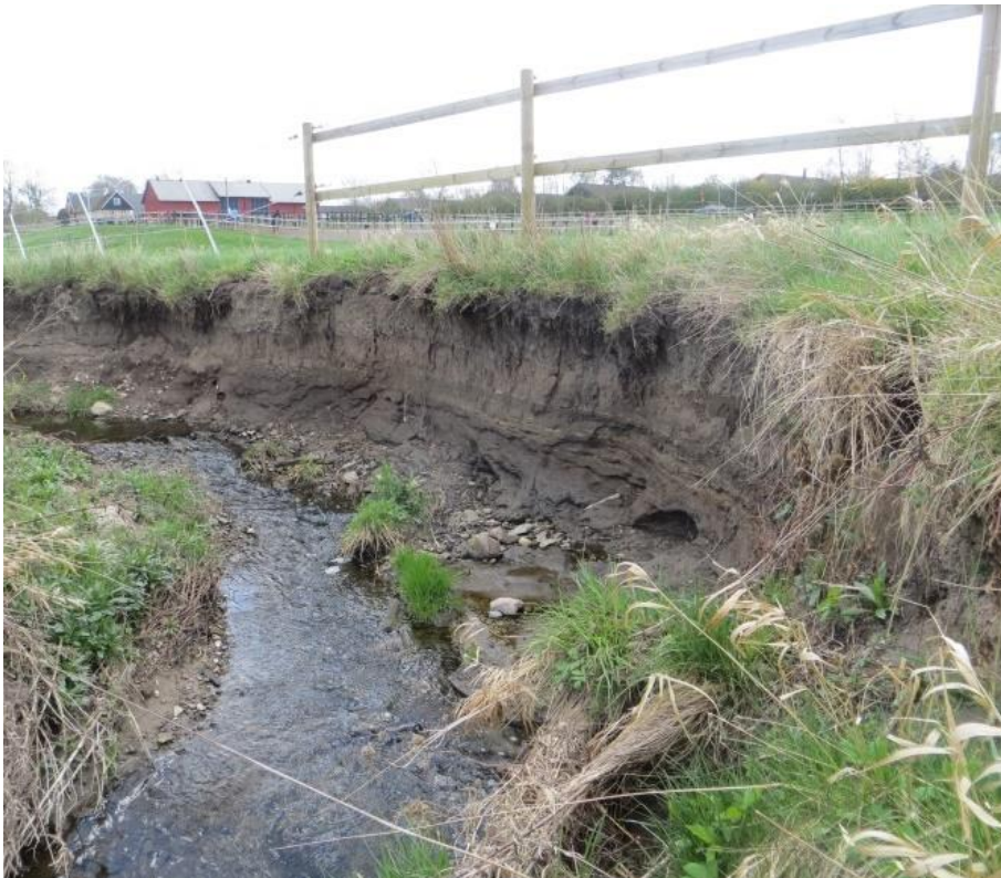
Figur 51. Vallkärrabäcken genom Vallkärra. Kraftig erosion av slänterna i de nedre delarna av Vallkärrabäcken genom hästhagen.
