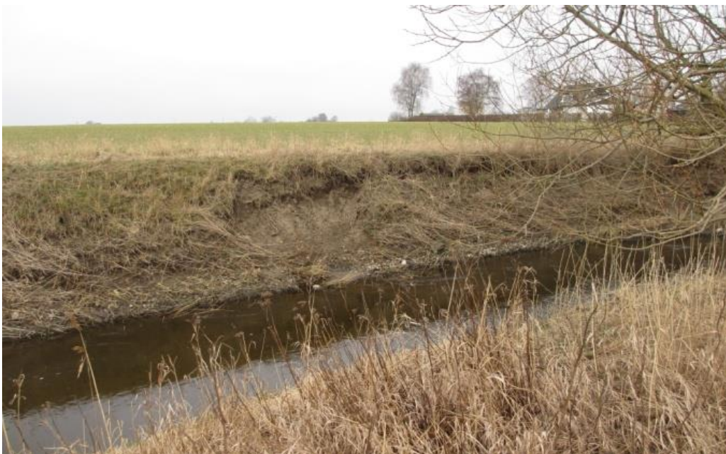
Figur 20. Höje å nedströms Kyrkheddinge. Erosion av åns västra slänt.
