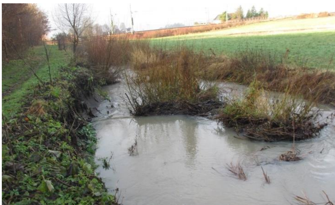
Figur 48. Vallkärrabäcken uppströms järnvägen. Piluppslag i mitten av bäcken har medfört att bäcken har blivit bredare än vad som är lämpligt när det är lågflöde.
