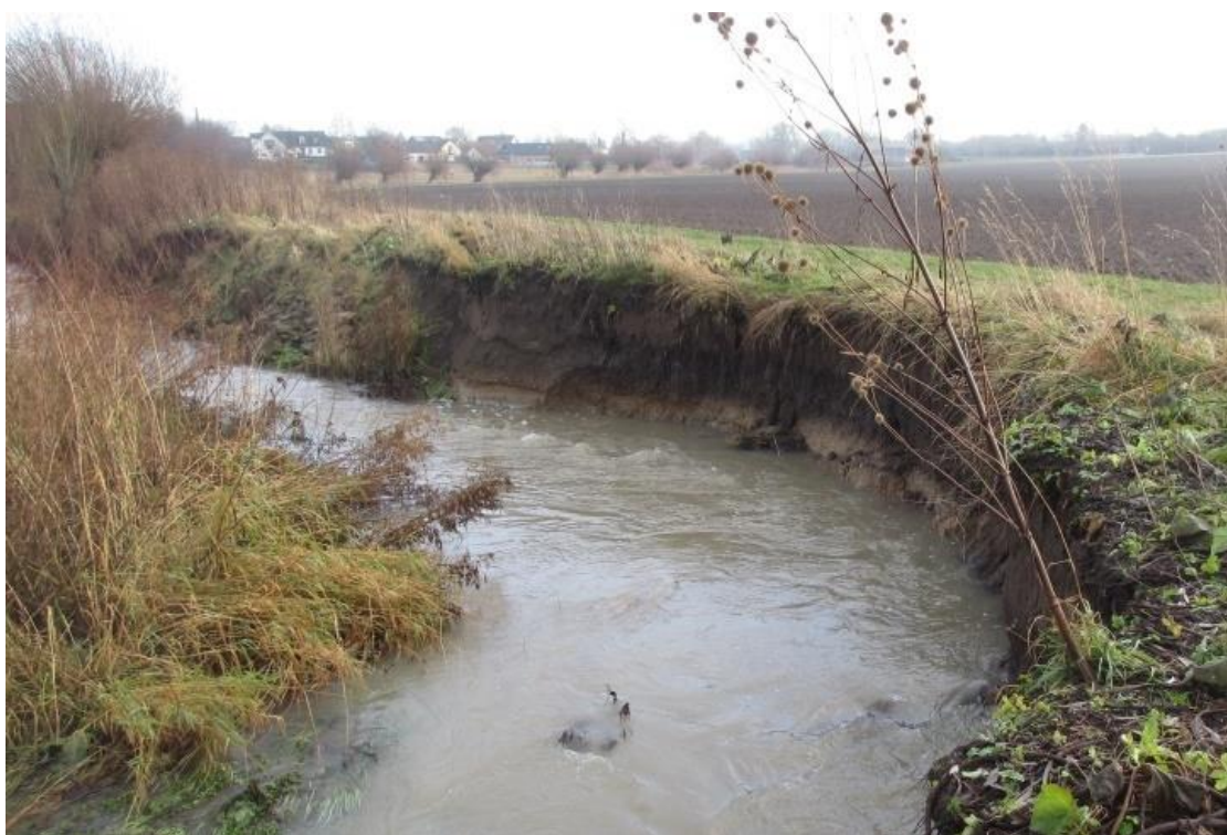
Figur 47. Vallkärrabäcken uppströms järnvägen. Erosion söder om bäcken. I bakgrunden syns åkern som kommer påverkas om erosionen fortsätter.
