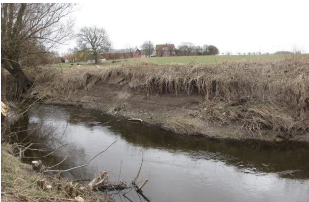
Figur 16. Höje å uppströms Råbydikets utflöde. Ytterligare erosion på slänten.
