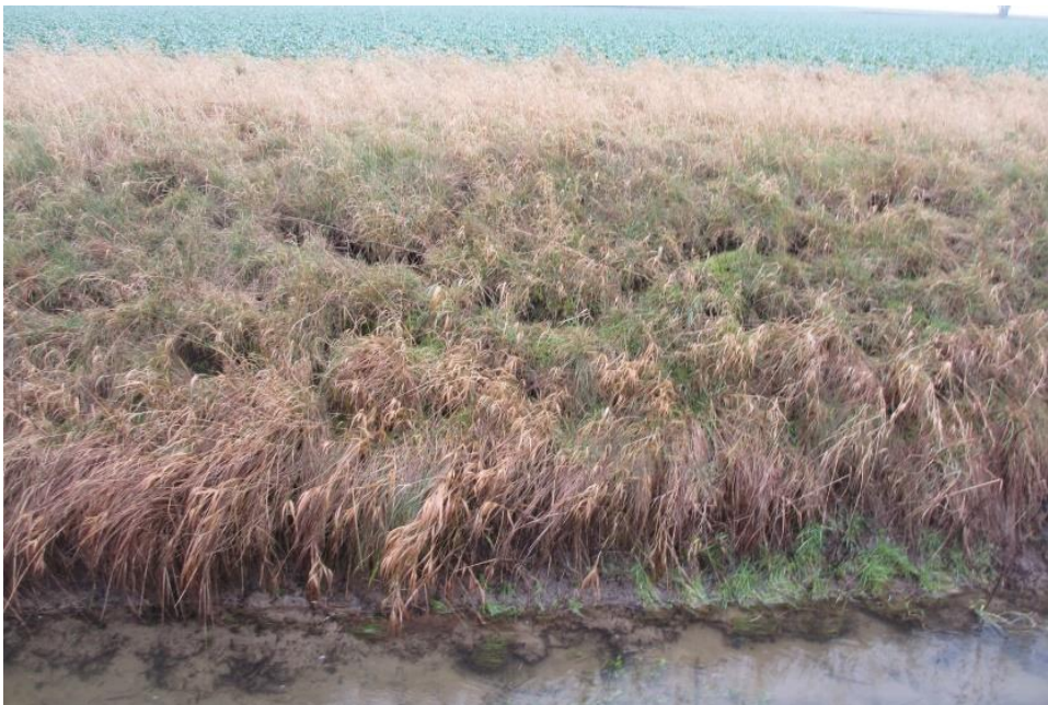
Figur 54. Dike nedströms Fels mosse. Erosion i slänten
