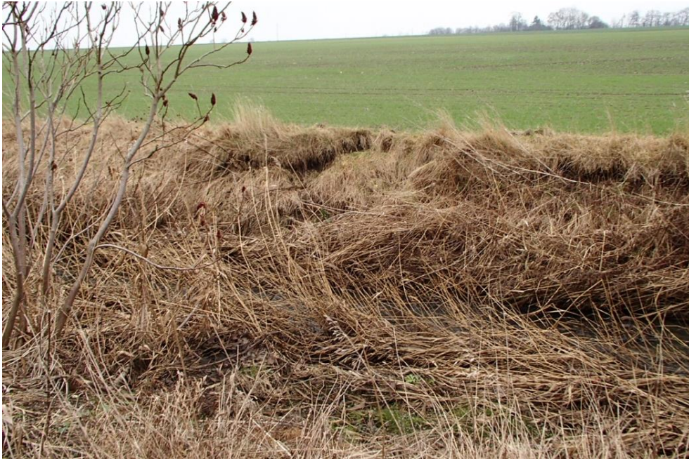
Figur 52. Vallkärrabäcken genom Vallkärra. Erosion av slänterna på slänt som angränsar till åkermark.
