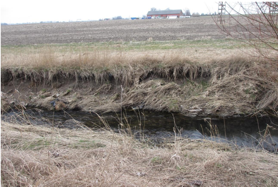
Figur 61. Råbydiket nedströms Lilla Bjällerup. Erosionsproblem i Råbydiket.
