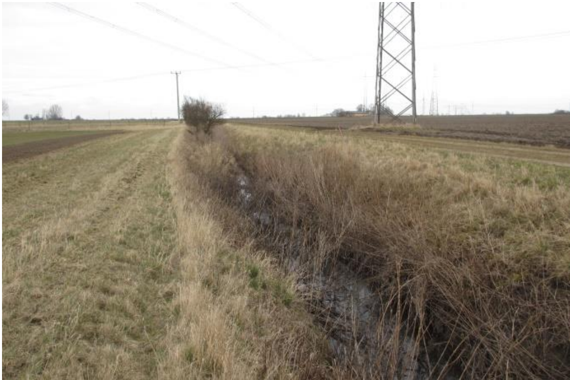
Figur 35. Önnerupsbäcken vid Laxmans Åkarp. Bäckens smalhet och låga djup. Anläggning av tvåstegsdike skulle därav inte generera så stora volymer schaktmassor.
