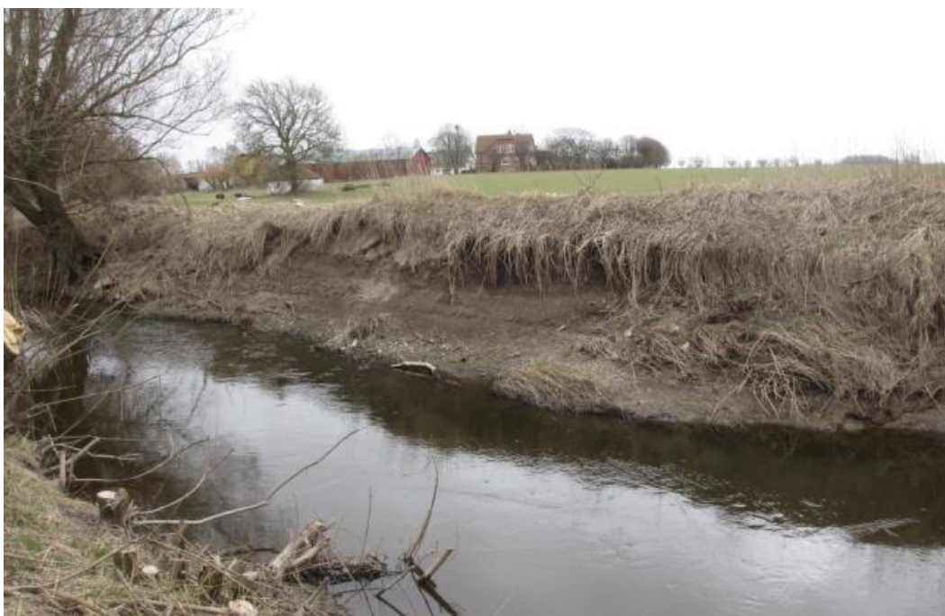
Figur 14. Höje å uppströms Råbydikets utflöde. Ytterligare erosion på slänten.
