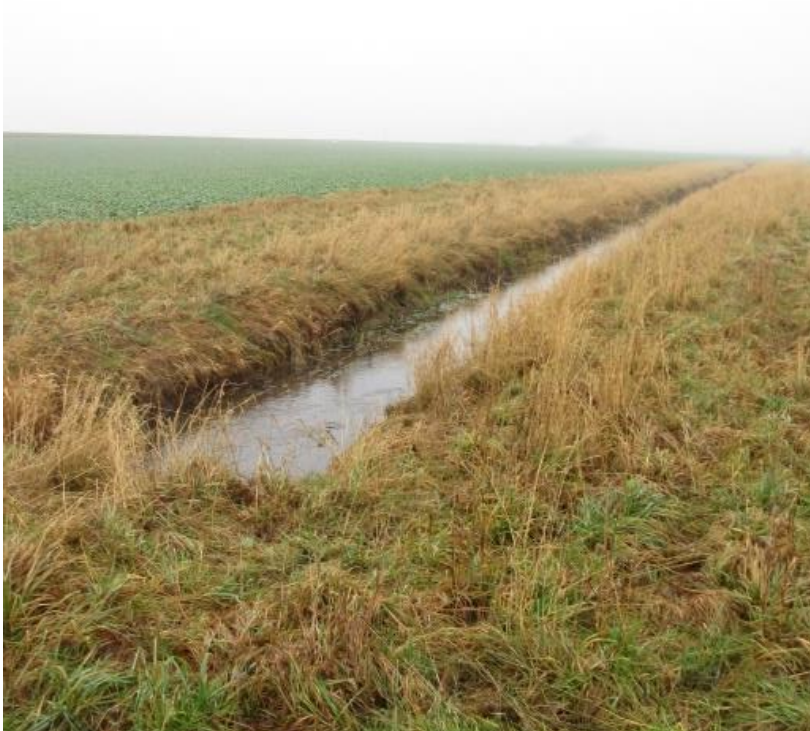
Figur 53. Dike nedströms Fels mosse. Ett rakt dike där det finns förutsättningar för att anlägga tvåstegsdike och minska erosionen.
