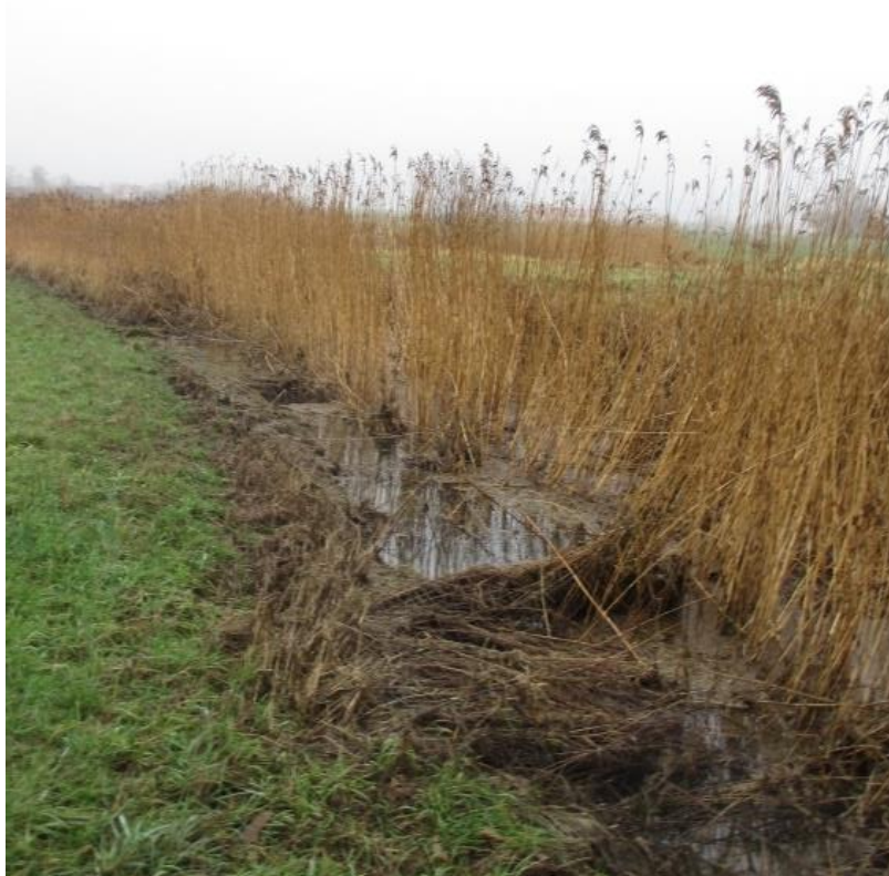
Figur 31. Önnerupsbäcken den östra grenen vid Flädie. Högt vattenflöde i Önnerupsbäcken vid kartering gjorde det svårt att urskilja erosion på slänterna.
