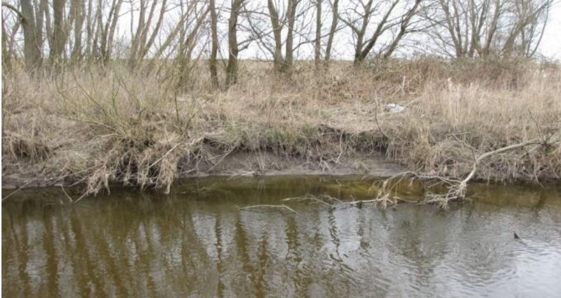
Figur 10. Höje å vid Knästorp. Erosion på den norra slänten av Höje å.
