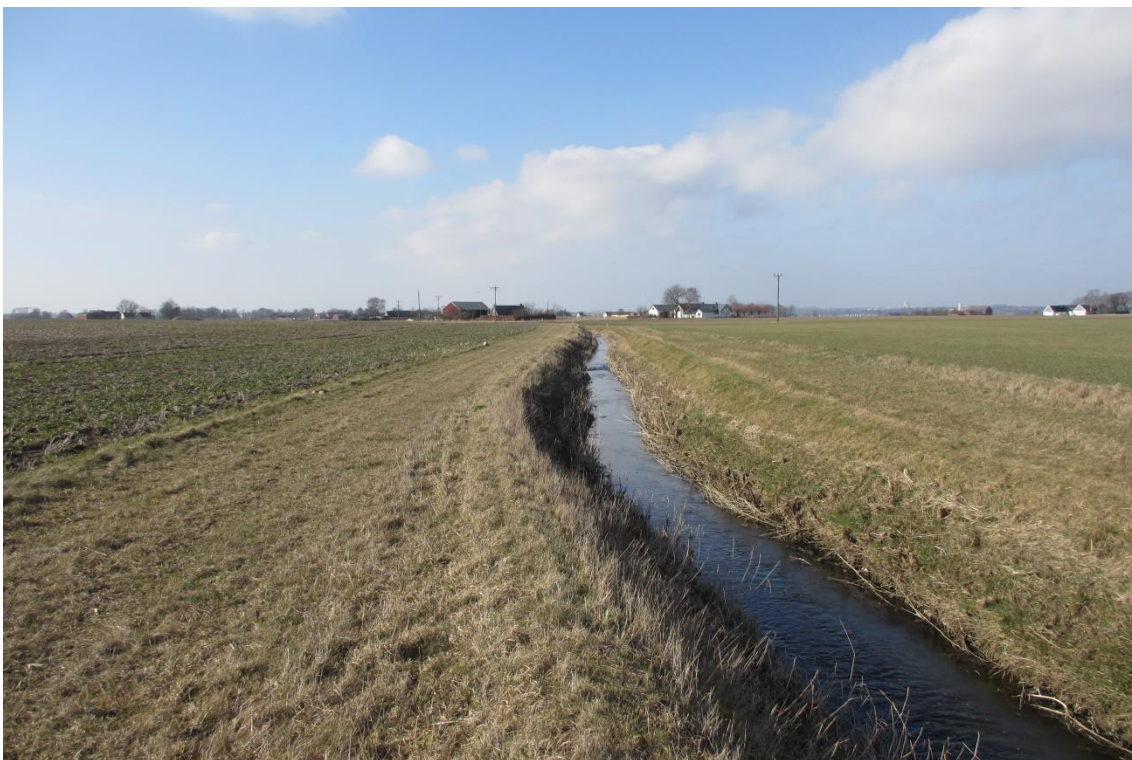
Figur 63. Dalbydiket vid Vallby. Ett rakt dike med relativt flacka slänter.
