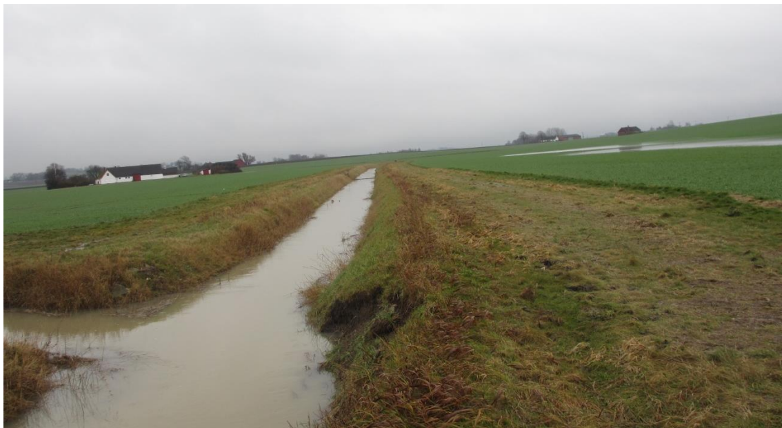
Figur 73. Dalbydike söder om damm på fastighet Dalby 21:27. Översvämning på åkern söder om diket.
