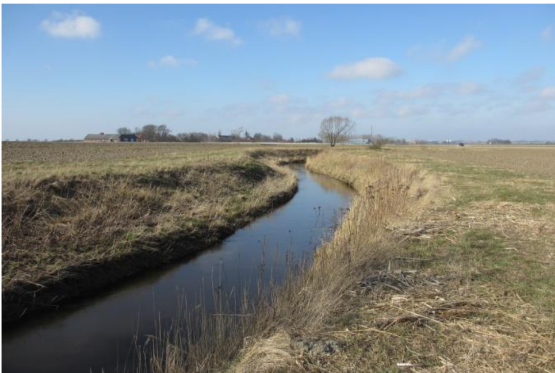
Figur 22. Höje å vid Trulstorp. Relativt flacka slänter söder om ån. Det har även bildats en liten terrass på åns östra sida.
