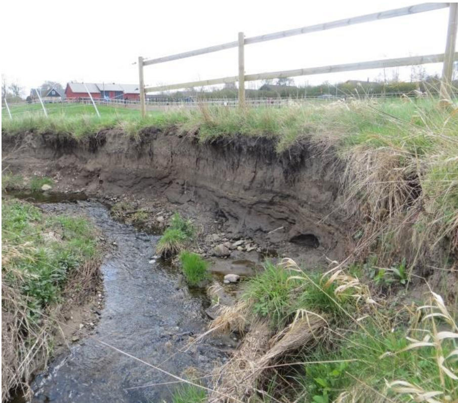
Figur 49. Vallkärrabäcken genom Vallkärra. Kraftig erosion av slänterna i de nedre delarna av Vallkärrabäcken genom hästhagen.
