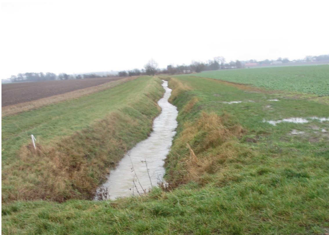
Figur 76. Dalbydiket nedströms damm på fastighet Dalby 2:5. Uppströms vägen syns inga tecken på erosion här är även slänterna något flackare.
