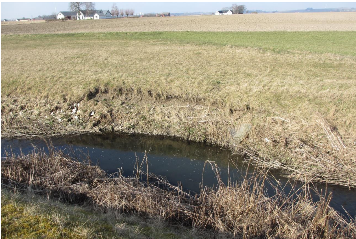
Figur 62. Dalbydiket vid Vallby. Det enda stället med erosion på den karterade sträckan.
