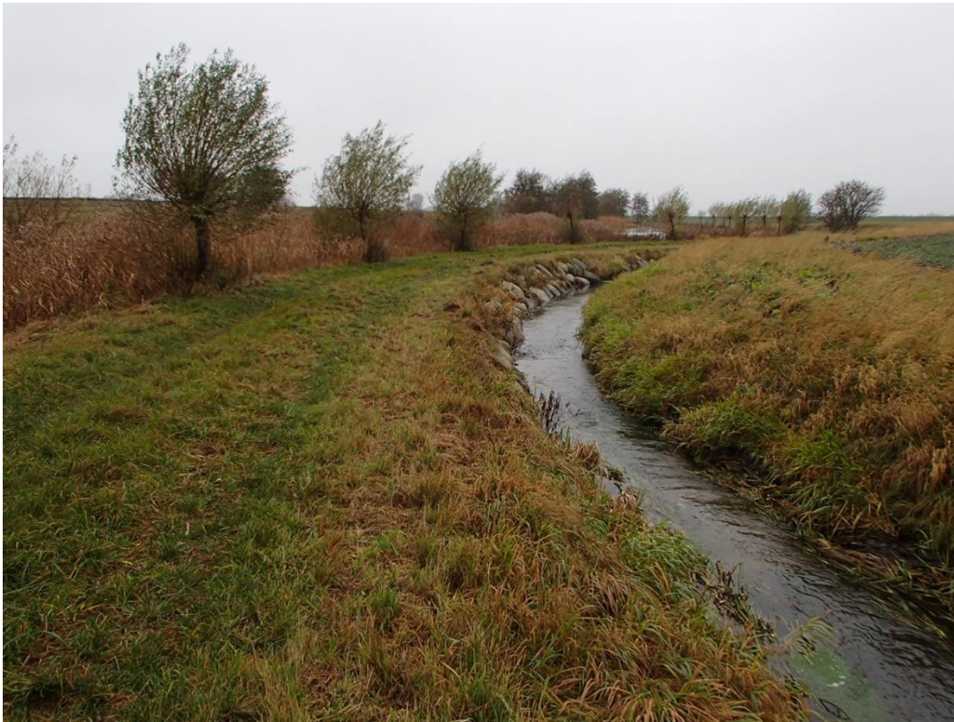
Figur 40. Vallkärrabäcken uppströms Fjellie. Stensatta slänter förbi dammen.
