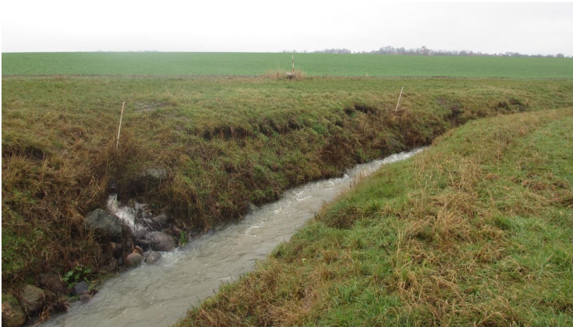
Figur 69. Dalbydiket uppströms reningsverket. Ytterligare erosion på de nedre delarna av den karterade sträckan. I det högra hörnet av fotot ligger stenar i slänten vilket kan vara ett försök att minska erosionen i diket.
