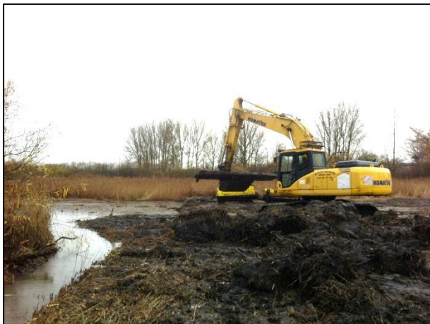
Figur 4 Schaktarbetena i mossens vassområden utfördes till stor del med hjälp av grävmaskinsmattor.
