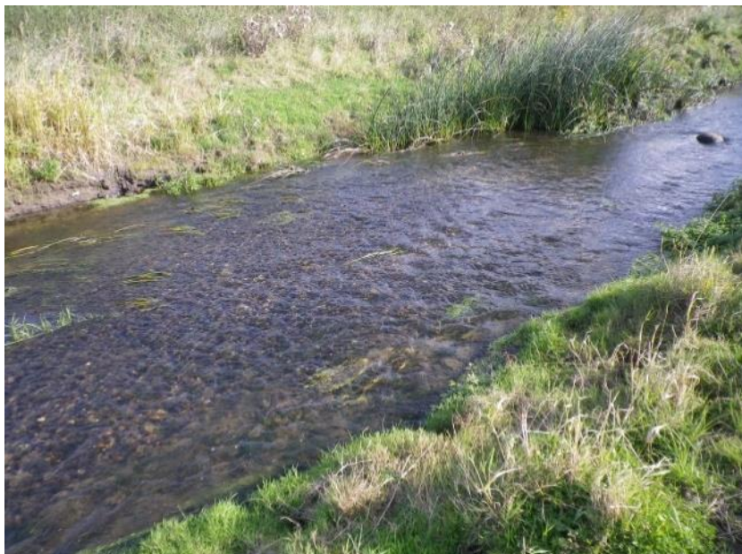
Figur 10 Anlagd grusbotten i den restaurerade meanderslingan vid Trolleberg.
