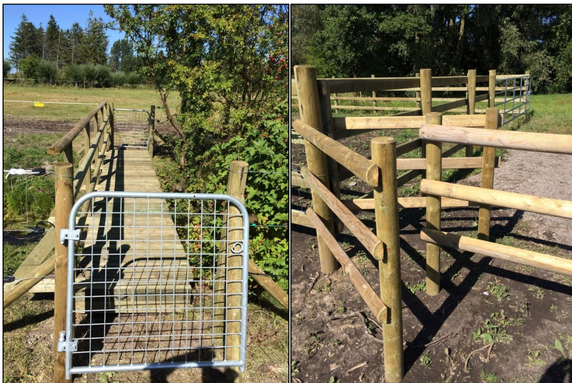
Figur 5 I samband med stängslingsarbetena gjordes flera tillgänglighetsfrämjande åtgärder som anläggning av en gångbro över huvuddiket (t.v.) samt ett stort antal stängselgenomgångar (t.h.).
