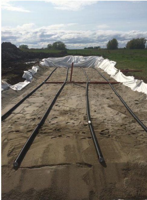
Hyttsanden är utlagd i bädden liksom uppsamlingsrörskiktet. Detta täcks sedan av ett makadamlager, geotextilduk och sist jord.
