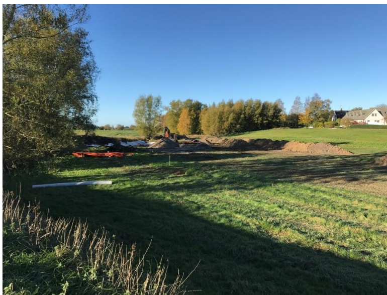
Bild 1: Översiktsbild från öst mot väst, från tisdagen den 24/10 2018. Filtergropen håller på att schaktas upp.
