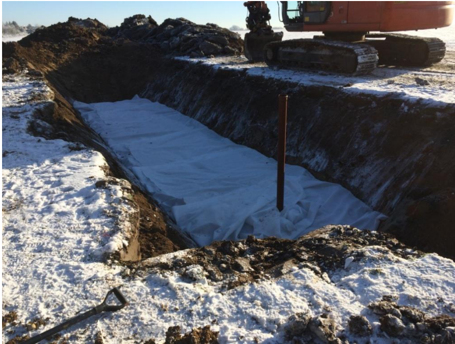
Fiberduken har vikts in ovanpå det översta makadamlagret och utgör ett skilje mot jordmassorna som ska täcka bädden, och även förhindrar att sedimentpartiklar förs ned med vatten till uppsamlingsskiktet.
