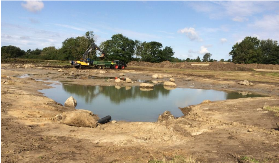
Dammen från den östra änden, under schakt.
