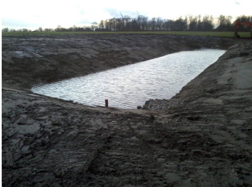
3 februari 2016. Dammschakten är klar och massorna har spridits ut på fyllnadsytan och jämnats till. Vattnet har stigit så mycket att det rinner genom kalkfilterbädden. Anläggningen har därmed tagits i drift.
