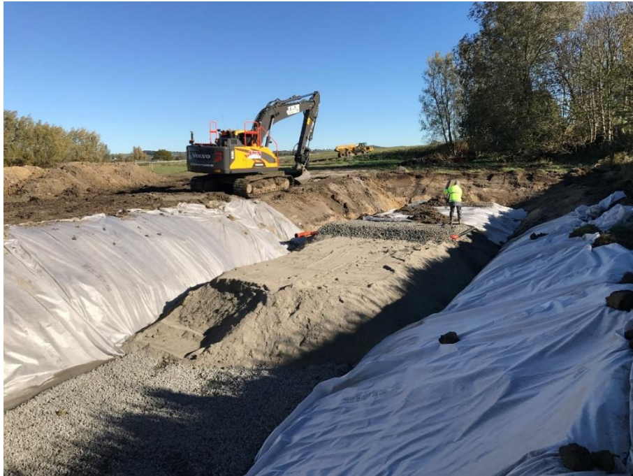
Bild 2: Bottenrören samt bottenmakadam (hyttsten) har lagts ut och hyttssanden håller på att läggas i bädden. I borte delen har även toppskiktet med makadam och uppsamlingsrör lagts ut.
