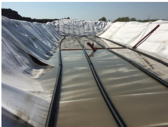
Kalkfilterbädden med bottenrör för vattendistribution utlagda.
