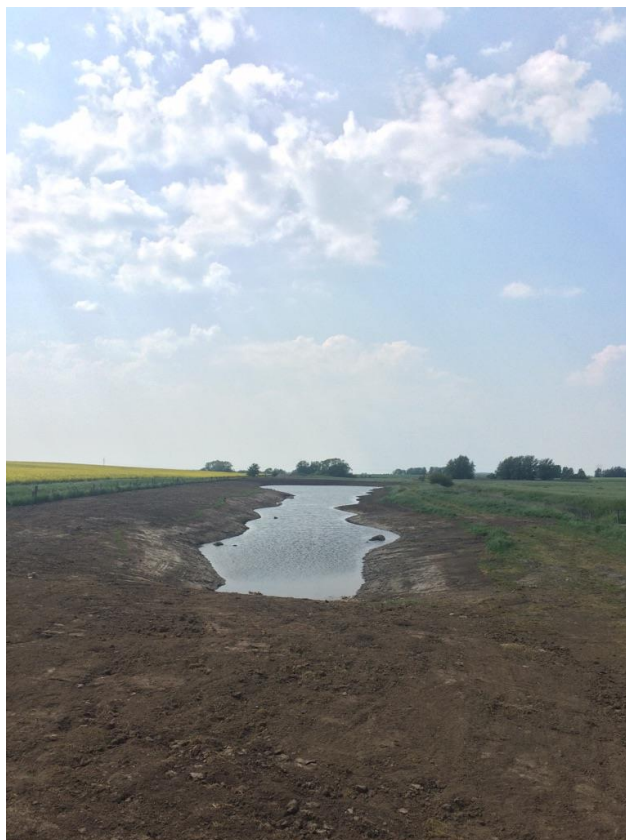
Fosfordammen färdigställd och vatten fylls på.
