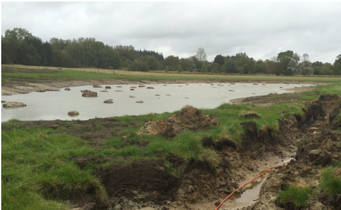
Dammen från den västra änden.
