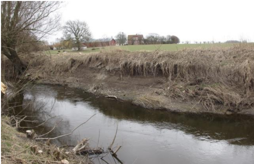
Figur 5. Höje å uppströms Råbydikets utflöde. Kraftig erosion har skett i slänten och ett tvåstegsdike kan vara en lämplig åtgärd på denna sträcka
