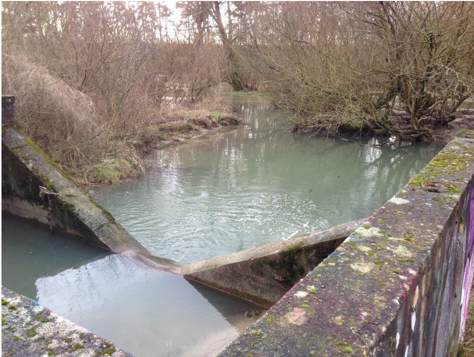
Figur 13. Utlopp för dagvatten i Värpinge (västra Lund). Bilden är tagen i slutet av januari vid högt flöde. Vattnet är fullt av suspenderat material, vilket ger vattnet den grumliga grå färgen. (Foto: Truls Olsson)
