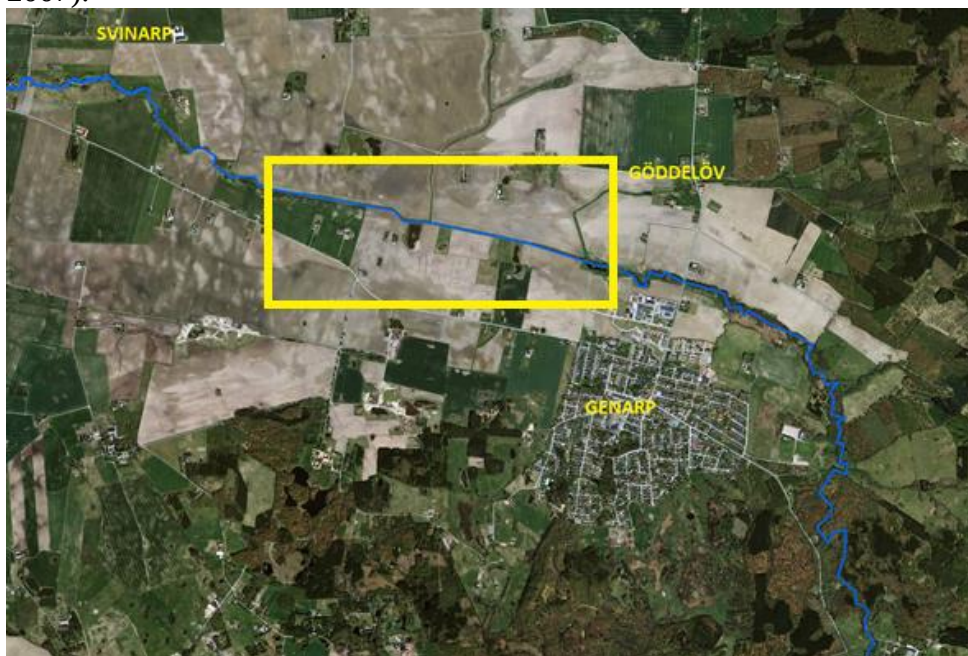
Figur 15. Höje å från Häckebergasjön precis utanför bild till Svinarp. Man ser tydligt att ån blivit kraftigt kanaliserad i jordbruksområdet mellan Genarp och Svinarp. Tvåstegsdike föreslås för den markerade sträckan.
