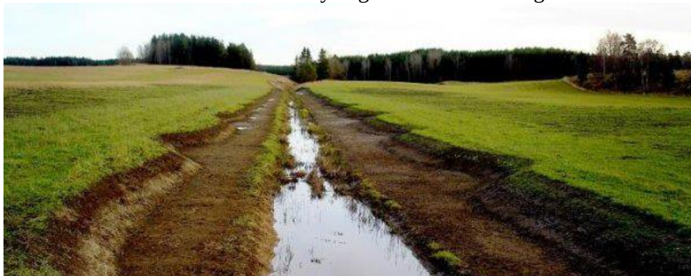
Figur 8. Nykonstruerat tvåstegsdike i Åkra, Nyköping. Här har den gamla botten och delar av det gamla dikets banker bevarats för att ge ökat ras- och erosionskydd innan ny vegetation hunnit etablera sig (Logardt, 2015).
