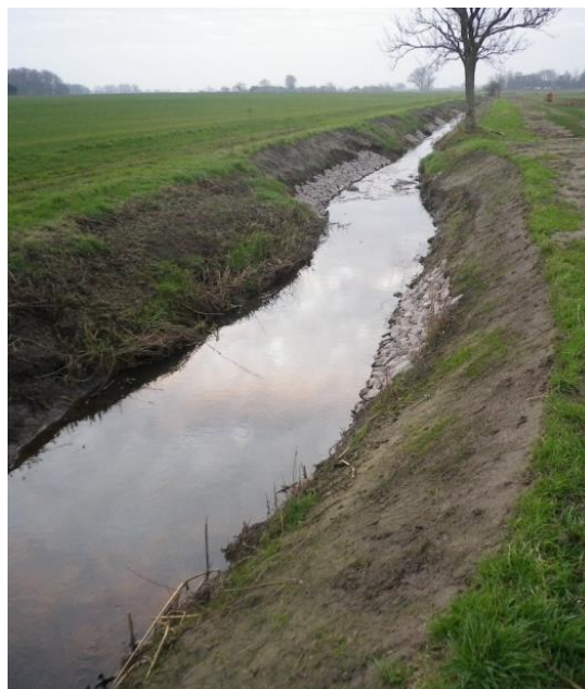
Figur 1 Sträcka av Önnerupsbäcken där avfasning och stabilisering av slänter samt anläggning av lekbotten utförts
