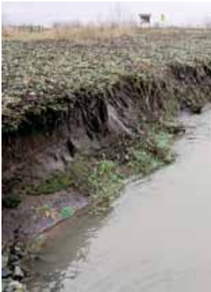
Vid en rensning är det viktigt att kanten inte görs för branta eftersom det kan leda till ras och ökad erosion i diket.
