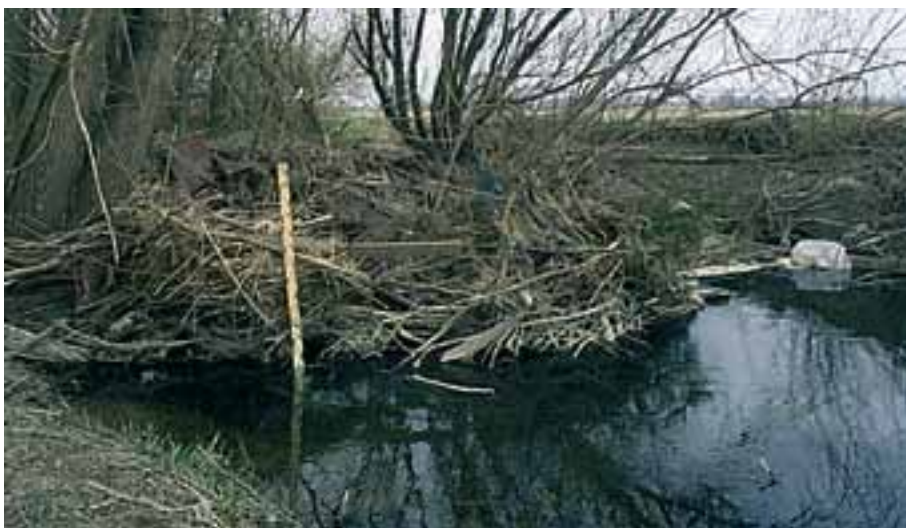
Material som transporterats med vattnet har ansamlats och bildat ett ordentligt hinder i vattendraget med en kraftig dämning som följd. Vid en rensning skall arbetet i första hand inriktas på att ta bort sådana hinder.
