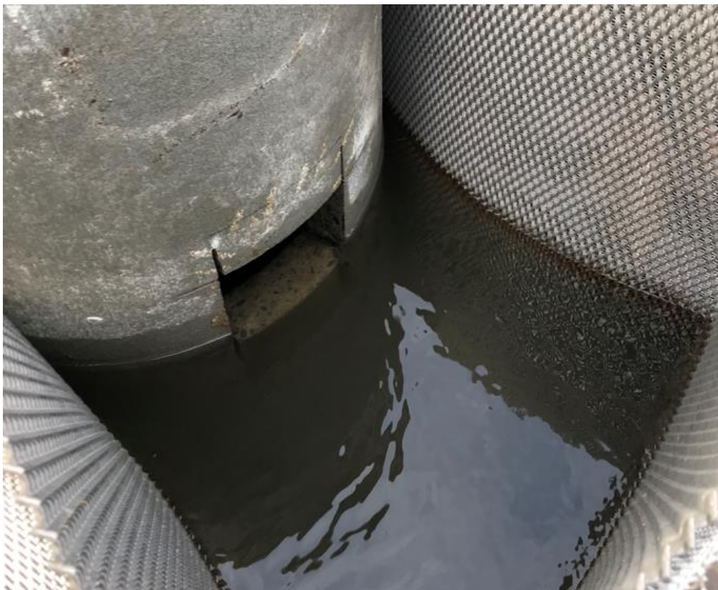
Figur 5. Intagsbrunn i damm, med 20x20 cm minitappningshål och finmaskigt nät för att skydda filterbäddarna mot igensättning. Efter mätperiodens slut flyttades det finmaskiga nätet till fördelningsbrunnen för ökad driftsäkerhet (men försämrad precision i regleringen av flödena till filterbäddarna).
