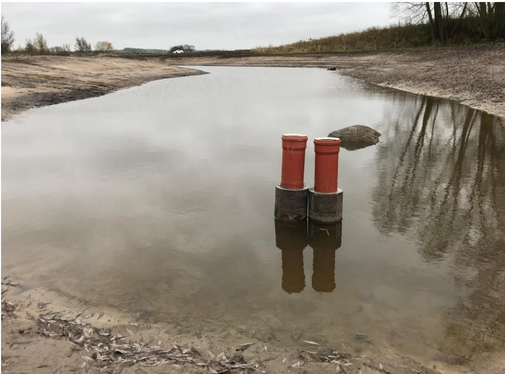
Figur 23. Inloppsror till filterbädden vid Lilla Bjällerup.
