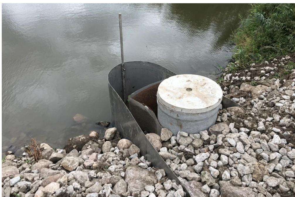
Figur 4. Intagsbrunn i damm med skyddsplåt och finmaskigt nät för att minska känsligheten för flytande vegetationsrester.
