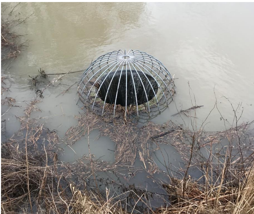
Figur 6. Breddavlopp i damm. Breddning sker när flödet genom dammen överstiger ca 100 l/s. Vattnet som passerar genom breddavloppet leds förbi fördelningsbrunnen och filterbäddarna.
