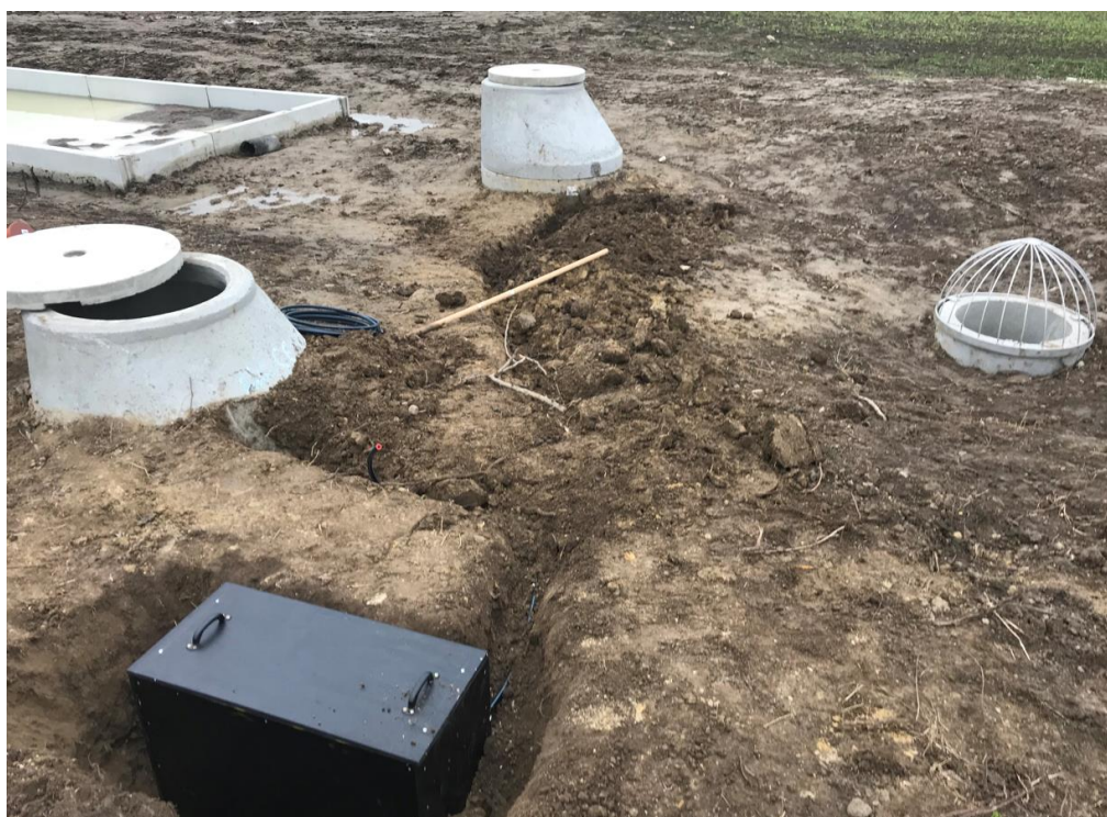
Figur 10. Installation av mätutrustning vid mätbrunnarna nedströms filterbäddarna. Jordkällare med isolerade lock användes för förvaring av uppsamlingskärl (25-litersdunkar) till provvattnet. Rör för provtagarslangar grävdes ner för att minska frekvensen av mätstopp vid minusgrader.
