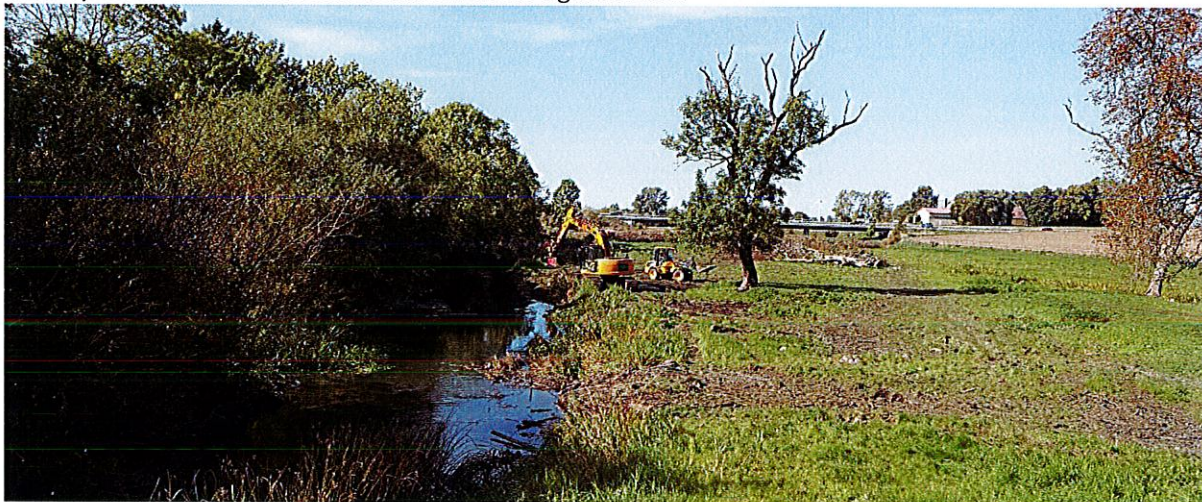
Höje å vid bron i Värpinge i september 2018. Entreprenaden med fiskevårdsåtgärder pågår för fullt.
