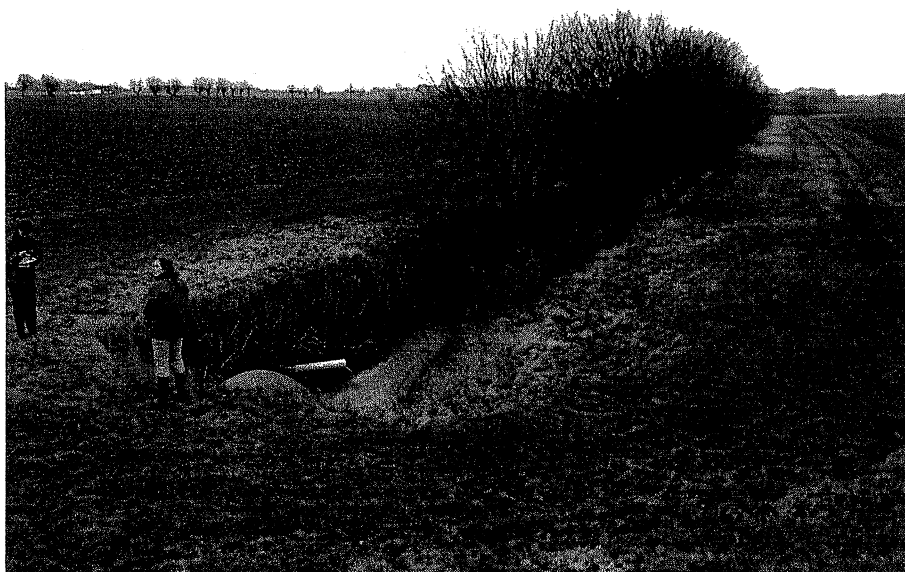
Figur 7. Första sträckan nedströms kulvert vid vägen söder om Stångby.
