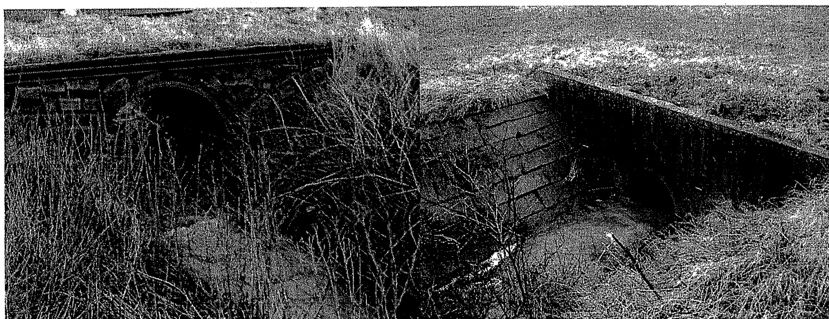
Figur 10. Bro mellan åkermark t.v. och inlopp till lång kulvert t.h.
