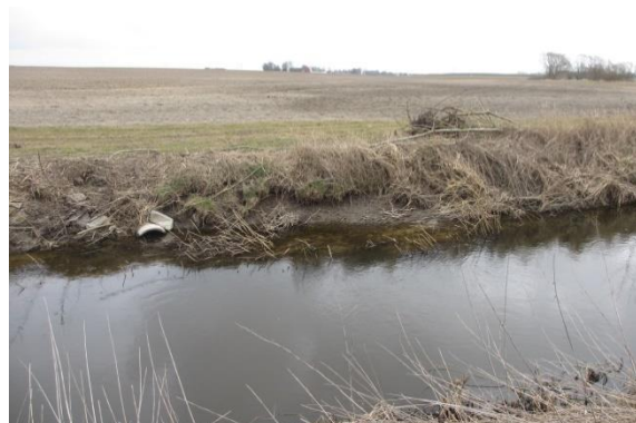
Figur 24. Vänstra bilden: dagvattenutsläppet öster om Knästorp. En sedimentbank har skapats precis nedströms utsläppspunkten. Högra bilden: uppströms Knästorp förekommer erosion av slänterna på kortare delsträckor.
