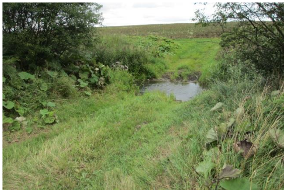
Figur 50. Vänstra bilden: traktorgenomfart i Höje å där slänterna är avfasade för att möjliggöra för en traktor att ta sig över till andra sidan av ån. Högra bilden: pestskräp och björnloka har etablerat sig i slänterna.
