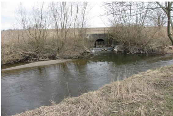
Figur 24. Vänstra bilden: dagvattenutsläppet öster om Knästorp. En sedimentbank har skapats precis nedströms utsläppspunkten. Högra bilden: uppströms Knästorp förekommer erosion av slänterna på kortare delsträckor.
