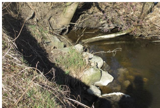
Figur 38. Vänstra bilden: på ett fåtal platser växer träden ut i åfåran. Högra bilden: stenar har lagts i slänten för att förhindra erosion.
