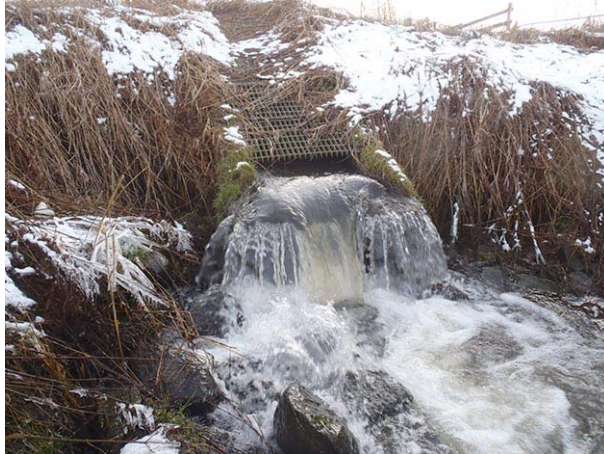
Utlopp från kulvert, medelflöde
