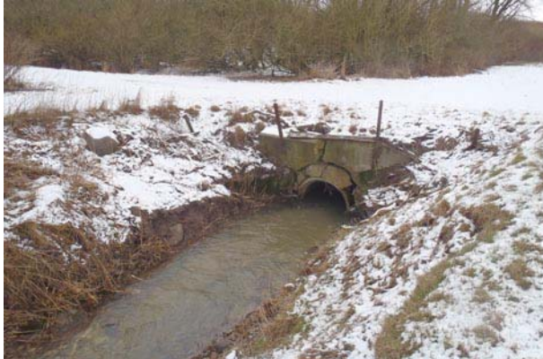
Övre delen av kulverten
