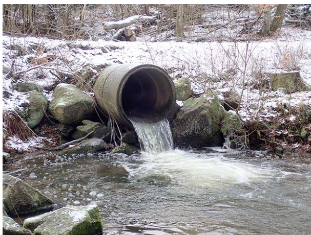
Utlopp från kulvert
