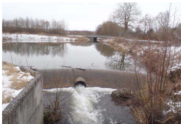
Dämnet med damm uppströms år 2012
