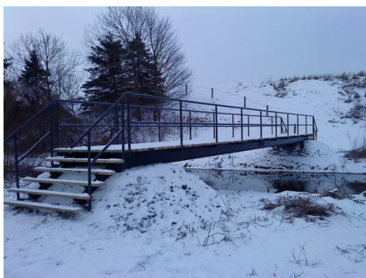
Figur 3 Den nyanlagda gångbron över Höje å knyter ihop det nya gångstråket med de befintliga stigarna på andra sidan ån. Foto: jan 2010.
