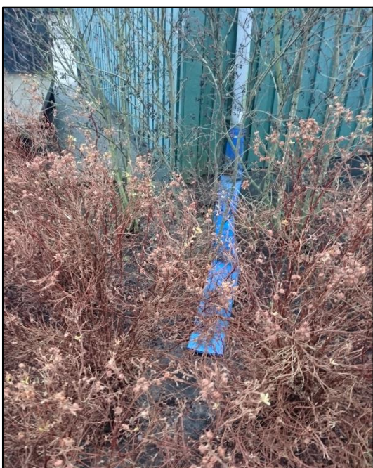
Figur 22 Befintlig utkastare från ett garagetak i Linero
