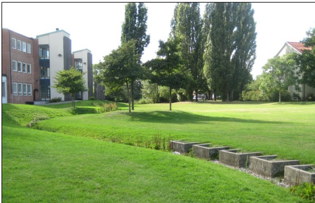
Figur 13 Grönyta intill dike som fungerar som översvämningssyta vid kraftiga regn (torr damm).
