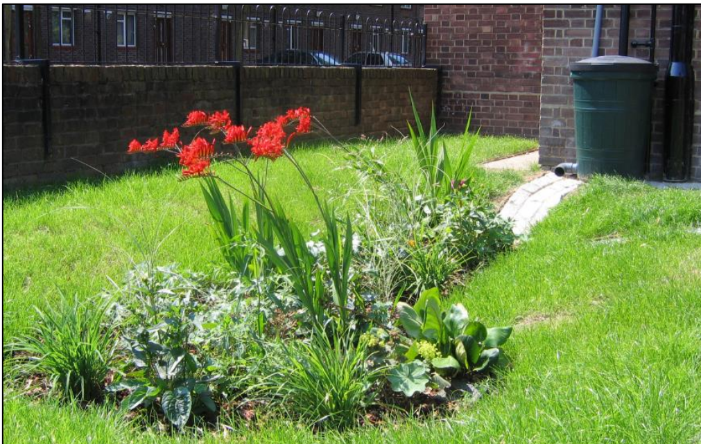
Figur 14 Regntunna och en regnbädd som tar emot vatten från takytor. (Bray m fl. 2015)
