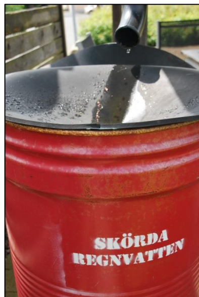
Figur 18 Regntunna, foto: Geraldine Thiery (från Tomellilla kommuns projekt "Skörda regnvatten")
