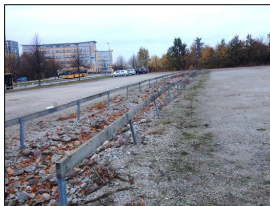
Figur 35 Befintligt krossdike på grusparkeringen som visas i Figur 34.
