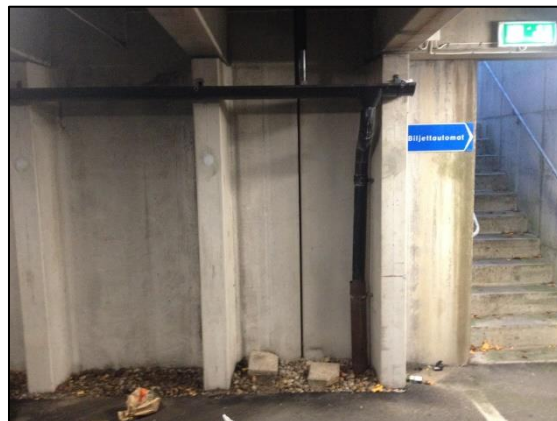
Figur 33 Exempel på stuprörskonstruktion i ett parkeringshus i Pålsjö. Vattnet från övre plan leds via brunnar och rännor direkt ner i ledningsnätet istället för att utnyttja den fördelaktiga höjdnivån för att omhänderta dagvattnet i en ytlig lösning.
