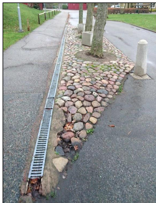
Figur 23 Befintlig ränna och hastighetssänkande åtgärd i Linero
