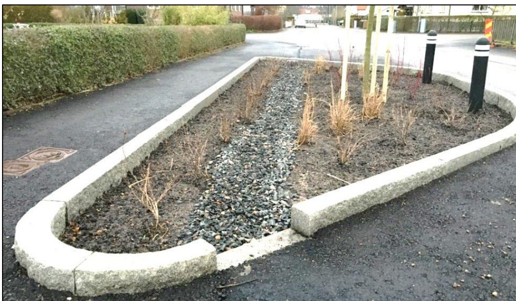
Figur 15 Regnbädd med en så kallad kantstenlösning (curb extension) som fungerar som farthinder på en villagata i Munka Ljungby.
