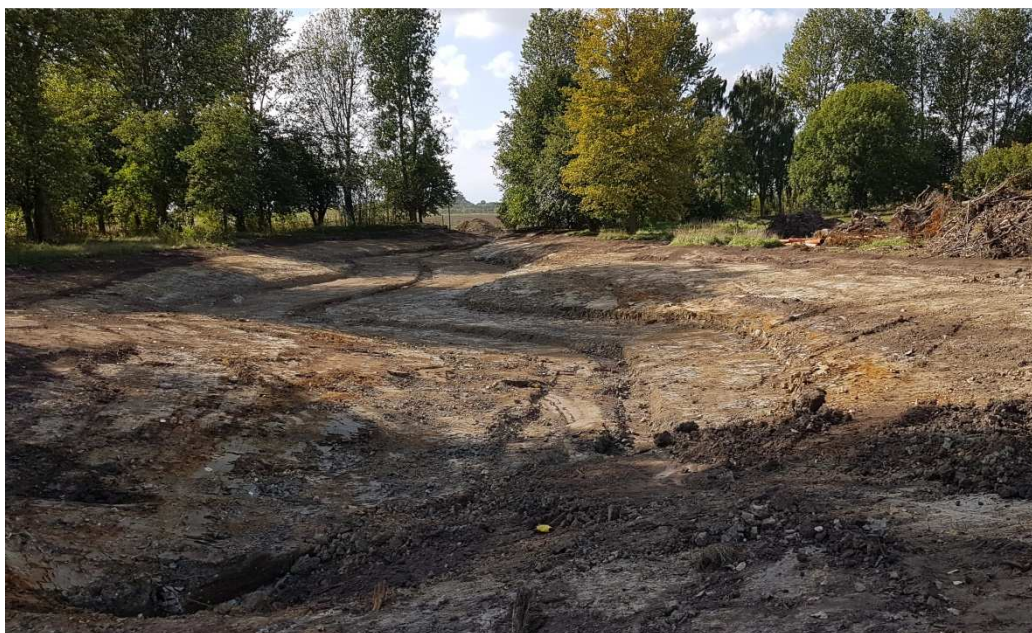
Pågående entreprenad i Vallkärratorn. Bäckens utformas som ett tvåstegsdike med översvänningszoner på delar av sträckan.
