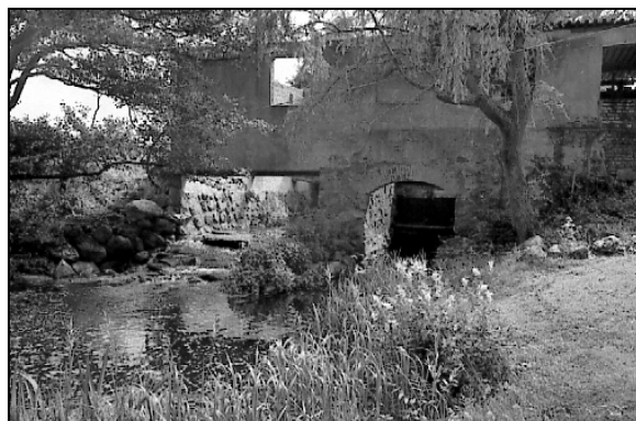
Nedströms kvarnbyggnad och hinder
