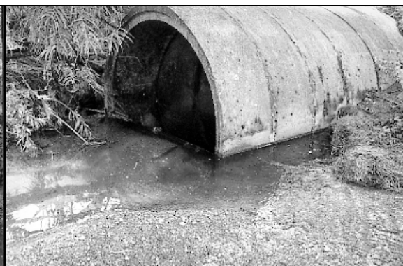
Övre delen av kulvert, tröskel på 0.5 m
