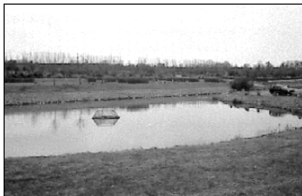
Uppströms kulvert, utloppet är i dammens mitt
