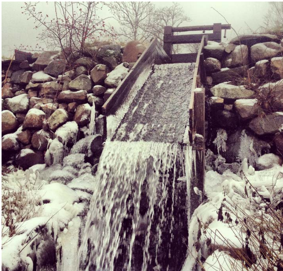
Skibord i trä och stendämme vid Gödelövsbäcken, ett biflöde till Höje å, Skåne län. Foto Jakob Marktorp 2013.
