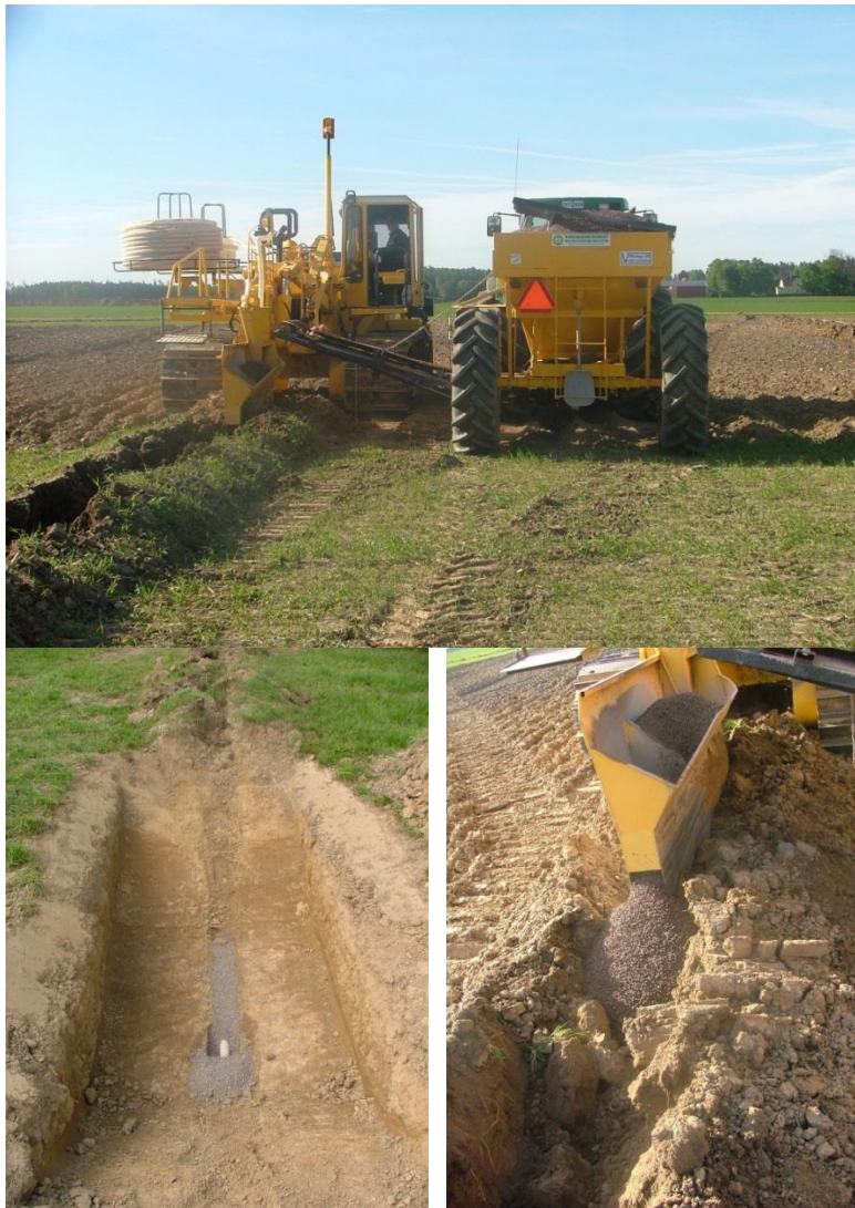
Figur 2. Modern täckdikningsteknik innebär att dräneringsrör av plast med grusfilter kring ledningen och filter mellan markytan och dränerir grävning av öppet schakt. (Foto:C-J Rangsjö)
