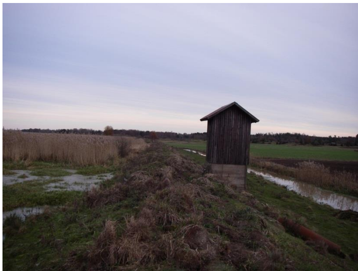
Figur 5. Invallning med vall, pumpstation, valldike och invallningsområde med åkermark. (Foto: C-J Rangsjö)
