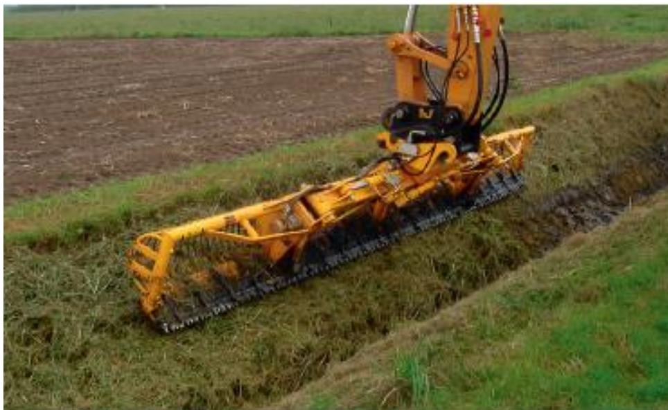
Figur 13. Underhåll av dike med klippskopa. (foto:C-J Rangsjö)
