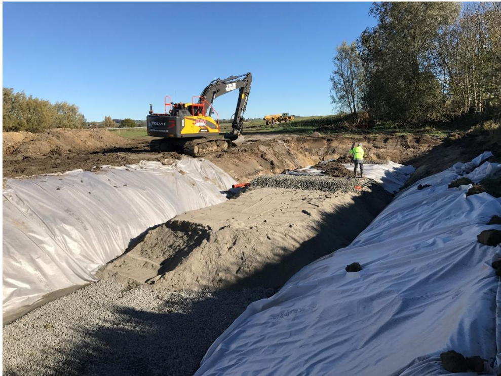
Bild 2: Bottenrören samt bottenmakadam (hyttsten) har lagts ut och hyttsanden håller på att läggas i bädden. I borte delen har även toppskiktet med makadam och uppsamlingsrör lagts ut.
