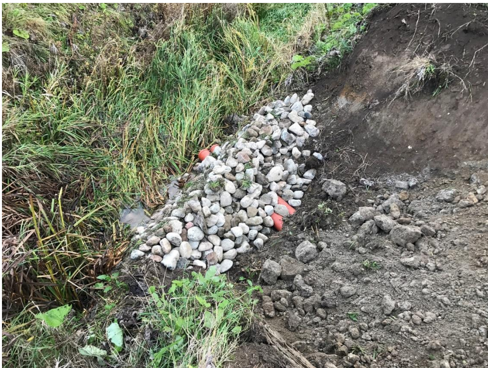
Bild 4. Inlopp och utlopp stensätts med kullersten och över den sprängsten. Här har kullerstenen lagts ut vid inloppsrören men ännu inte sprängsten.
