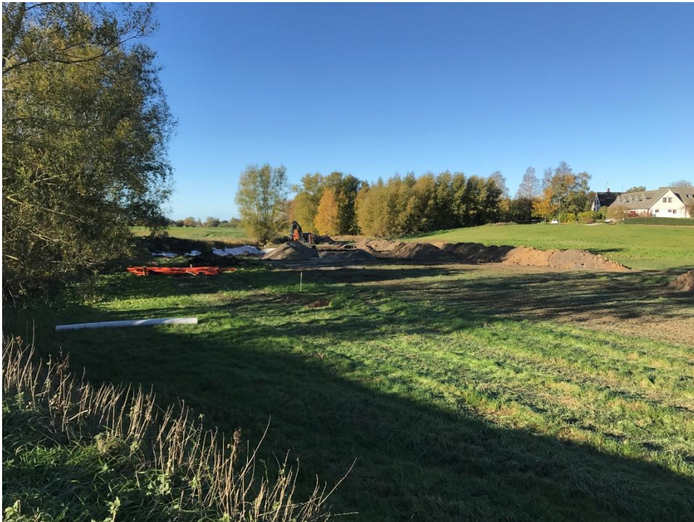
Bild 1: Översiktsbild från öst mot väst, från tisdagen den 24/10 2018. Filtergropen håller på att schaktas upp.
