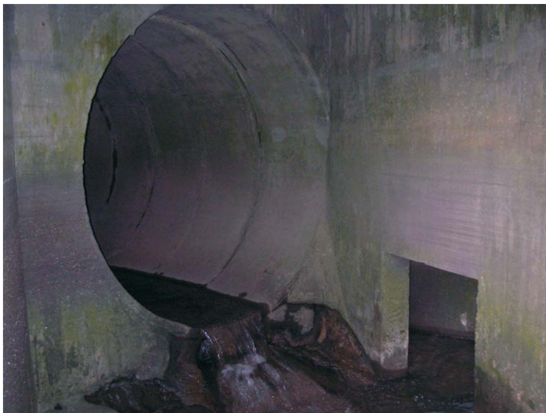
I kulverten från Norra Fäladen under järnvägen. Diametern är ca 2,3 m.
