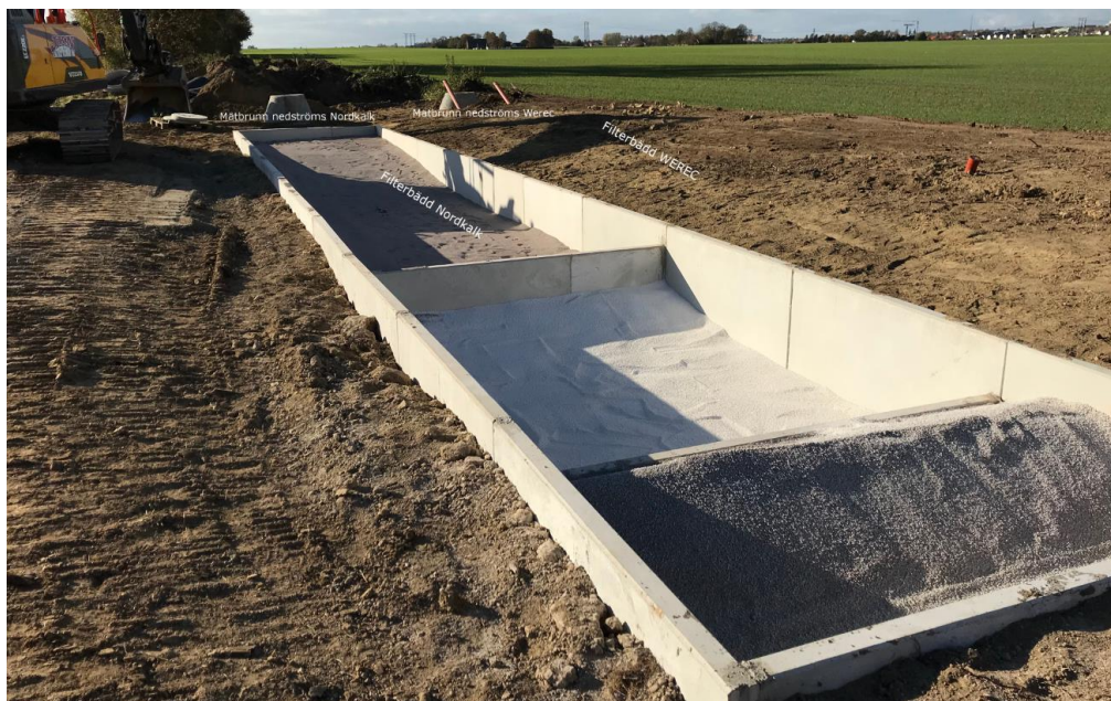
Figur 9. Filterbäddarna som de såg ut 2018-10-23. Nordkalks bädd i till vänster i bild och WERECs bädd (som är täckt med jord) till höger i bild. Vattenflödet går från kameran i bild.
