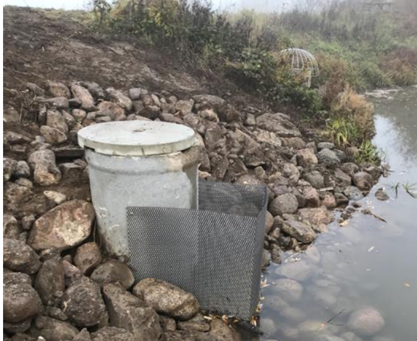
Figur 5. Intagsbrunn i våtmark, med 20x20 cm minitappningshål och silande galler i förgrunden. Den gamla utloppsbrunnen som syns i bakgrunden fungerar fortfarande för breddning av högre flöden ( >97 l/s), medan det gamla minitappningshålet är igensatt till förmån för det nya.
