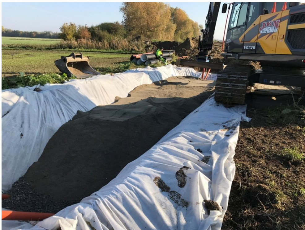
Figur 7. Anläggning av WEREC filterbädd. Bottenrören samt bottenmakadam (hyttsten) har lagts ut och Hyttsanden håller på att läggas i bädden. Uppsamlingsrören håller på att täckas med ett makadamlager (hyttsten). Därefter läggs fiberduk på makadamen och sist jord. Bild: Sam Ekstrand, WEREC.
