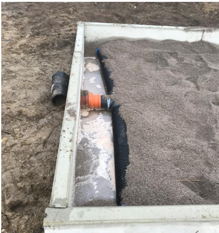
Figur 10. Utloppet på Nordkalks filterbädd. Ett 160 mm dräneringsrör används för uppsamling av vatten längs hela bredden (3 m) av bädden.
