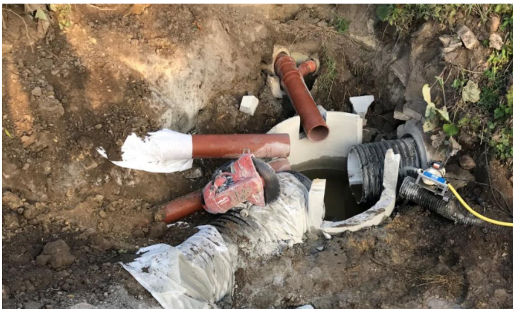
Figur 1. Uppsamlingsbrunnarna var utmanande att få ihop. Bilden visar samma uppsamlingsbrunn som i figur 11 under omkonstruktion. D500-rören som på bilden ligger instuckna i D600-ledningarna byttes ut mot D600-rör. Den nedre delen av brunnarna murades ihop för hand för att få täta anslutningar (se figur 13)
