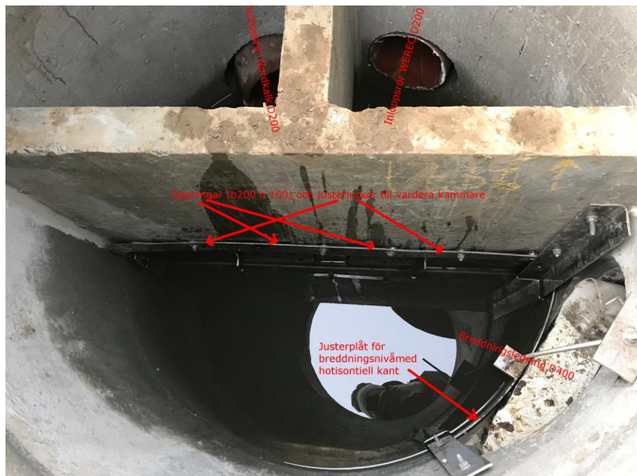
Figur 6. Fördelningsbrunn. För att skapa ett jämnt lågt flöde till vardera filterbädden konstruerades en fördelningsbrunn av trekammarmodell med justerbart breddavlopp och justerbara intag till filterbäddarna. Fördelningsbrunnen är robust, underhållsfri och ger möjlighet att stänga av, stresstesta och finjustera flödena till filterbäddarna. Inloppsriret till brunnen ligger under vattenytan i kammaren nederst i bild.
