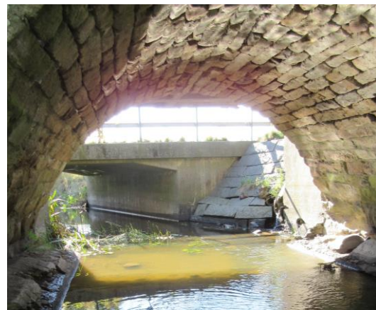
Figur 2. Underkanten på brovalvet på Kyrkheddinge bro användes för att konnektera markavvattningsföretagets lokala höjdsystem med RH 2000.
