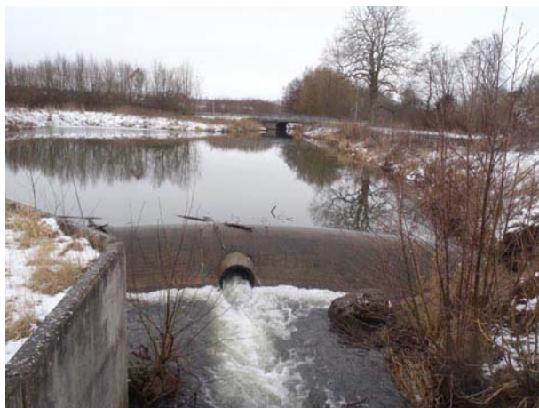
Dämmet med damm uppströms
