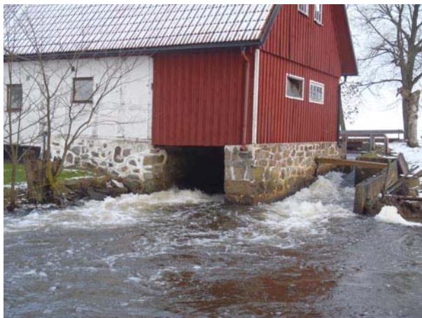
Utlopp vid kvarn på åns södra sida
