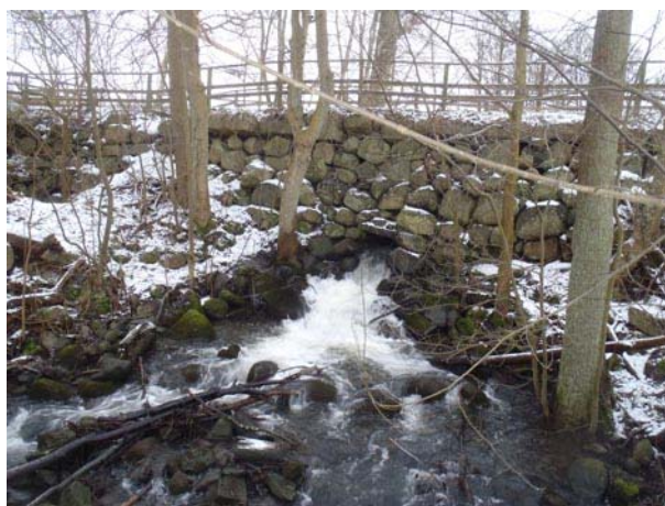
Utflödet mitt på dämmet
