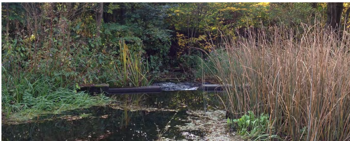
Figur 5.4: Den befintliga fiskvägen vid Lilla Harrie valskvarn utgörs av en urfasning i betongdämnat.
