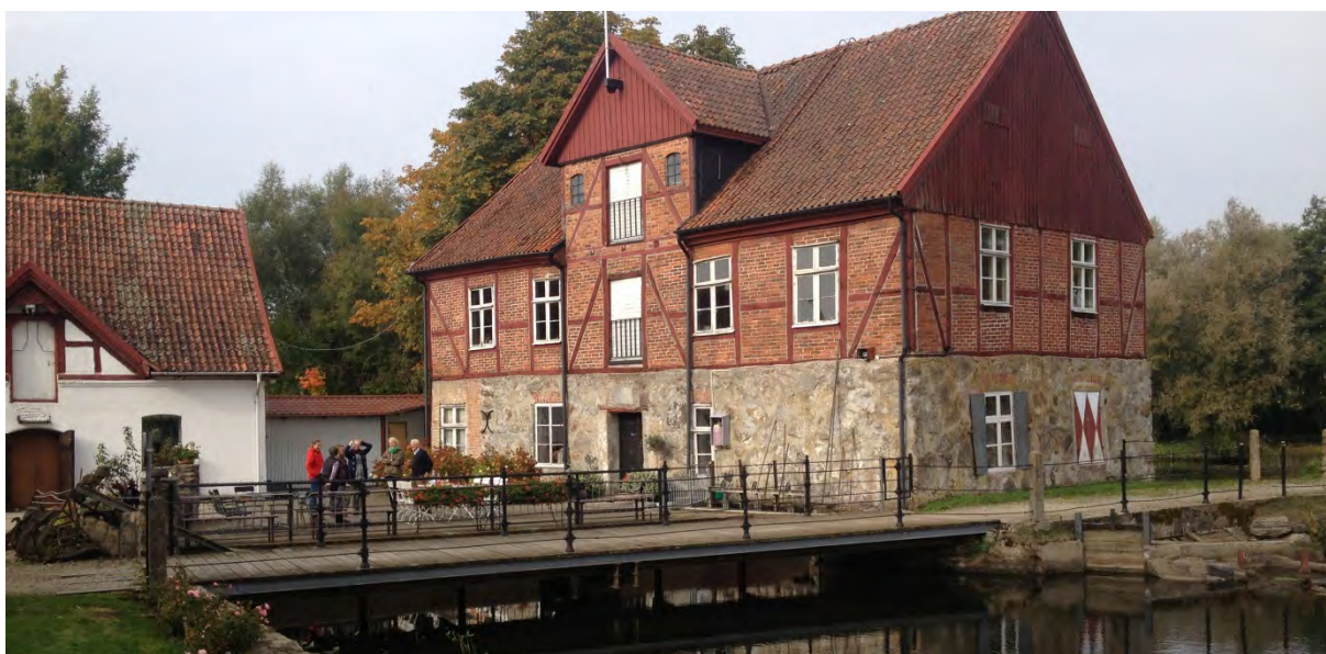
Figur 5.5: Bösmöller, ett av de tre aktiva vattenkraftverken i Kävlingeån. Kraftverket genererar ca 200-300 MWh per år (Vattenkraft.info - Information om Svensk vattenkraft 2014), ett modernt genomsnittligt vindkraftverk producerar ca 3 000 MWh per år (Svensk vindenergi 2015).
