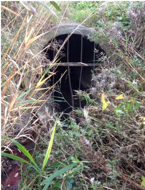
Figur 3.10: Strax nedströms Nöbbelövs mosse rinner hela Vallkärrabäcken in i en 800 m lång kulvert.
