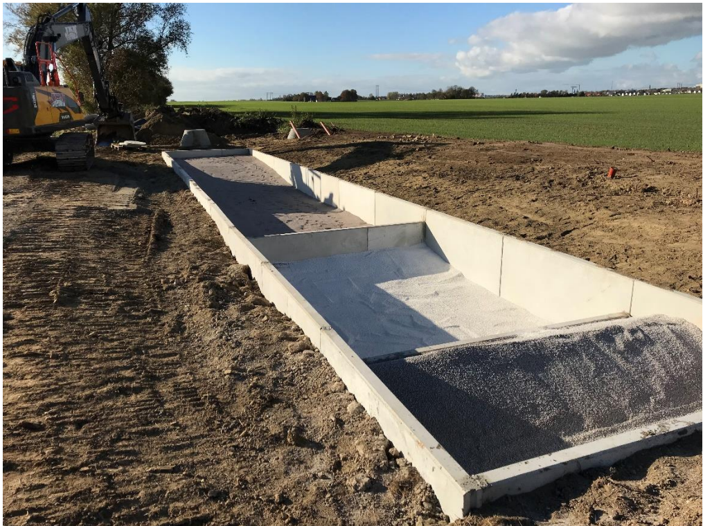
Anläggning av fosforfilter nedströms damm vid Råbytorp, Höje å Åtgärdsprogram.
