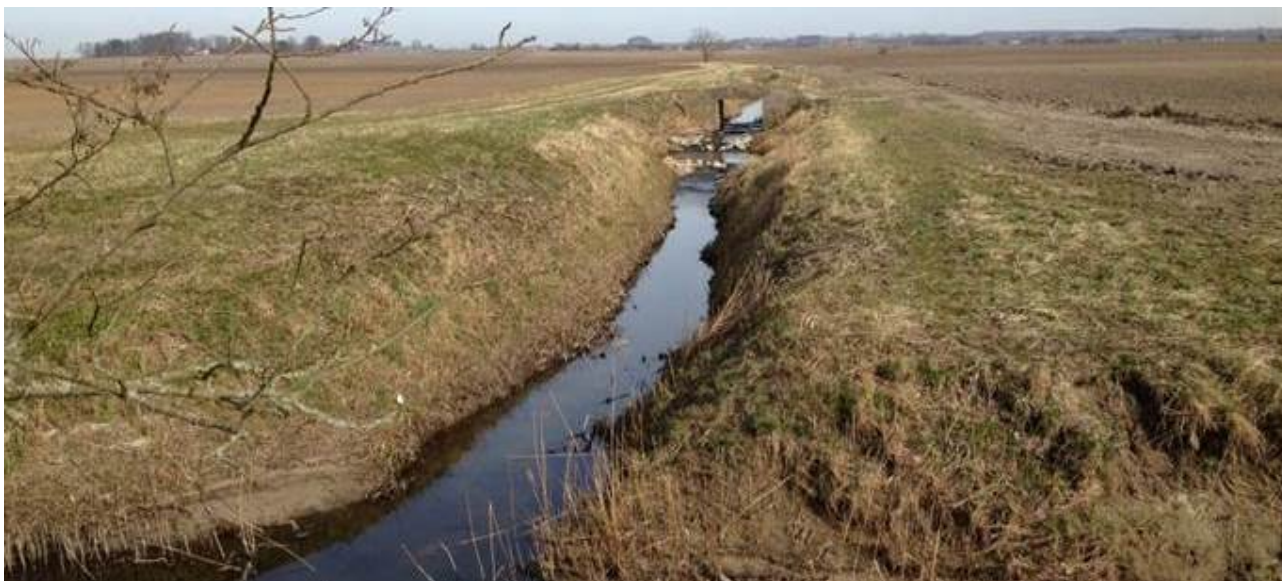
Ett typiskt uträtat och fördjupat vattendrag i de jordbruksintensiva delarna av Höje å avrinningsområde. Foto: Jonas Johansson
