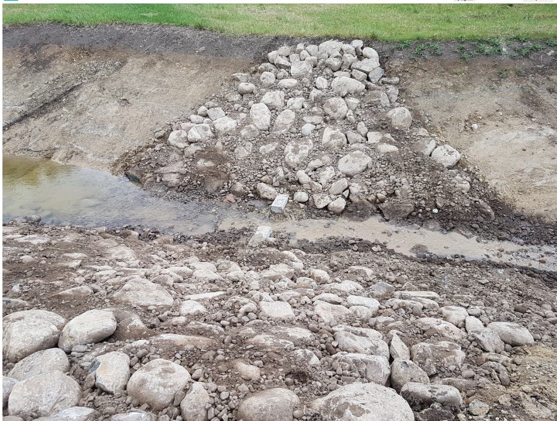
Figur 4. Dämme som fördelar vattnet i Råbydiket mellan dammarna och diket.
