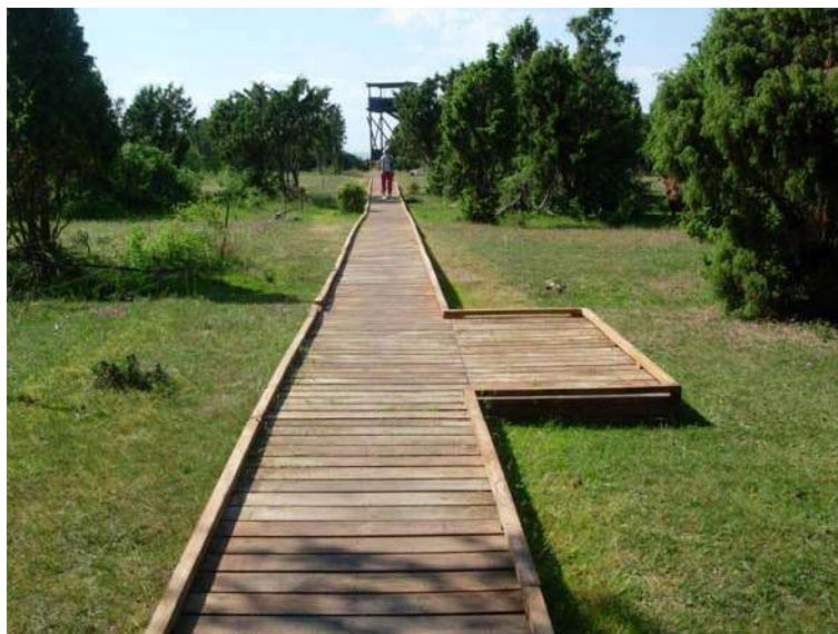
På sträckor med begränsad bärighet i marken, som i Gullåkra mosse, kan funktionshinderanpassade stråk anläggas som jämnt lagda trätrallor med mötesplatser på strategiska punkter.
