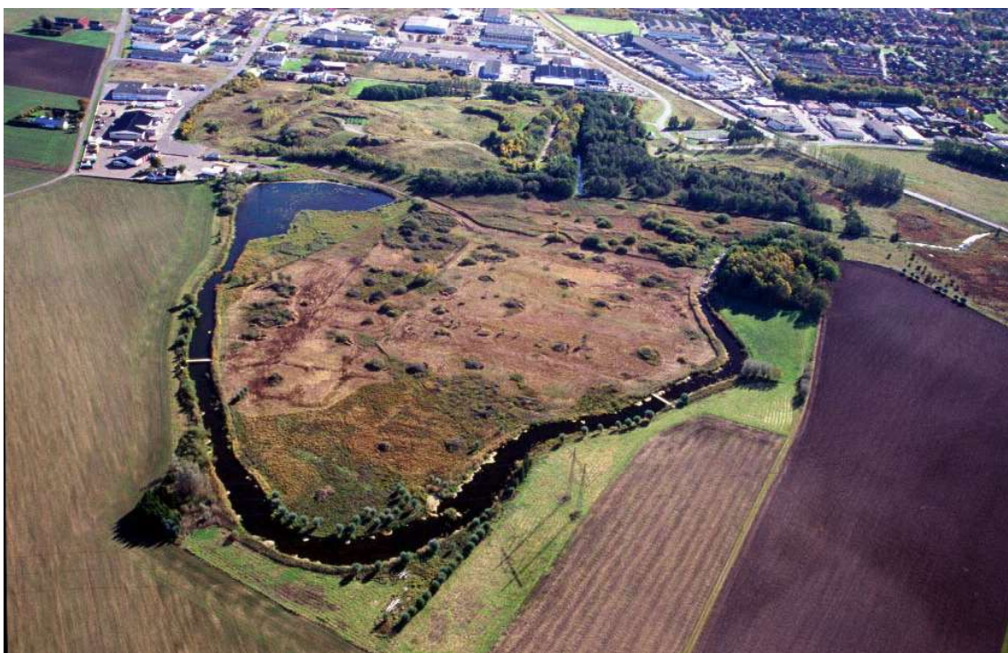
Vesums mosse vid Staffanstorps under pågående restaureringsarbeten hösten 2003.
