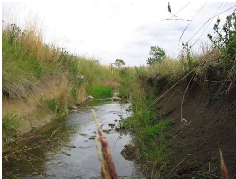
Erosion i dike vid Lunnarp
