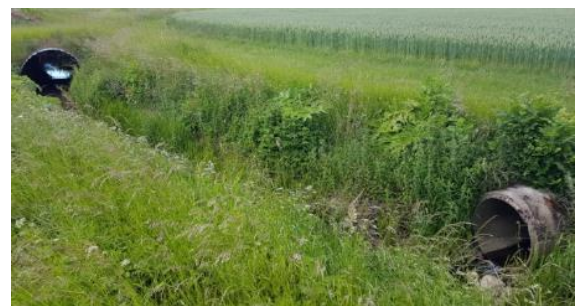
Råbysjön mynnar ut i ett öppet dike som efter cirka 600 m övergår i en kulvert som är 1750 m lång. Ovan visas kulvertens utlopp till Råbydiktet (ledning till höger). Ledningsdimensionen är 1000 mm.
