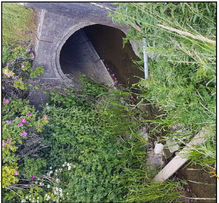
Trumma under Lilla Bjällerupsvägen
