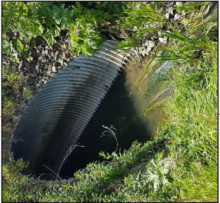
Trumma under Bjällerupsvägen
