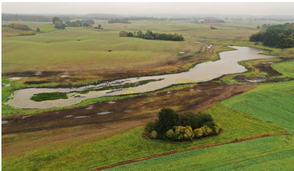
Figur 4. Bild från slutbesiktning. Foto: Karl Asp, Höje å vattenråd
