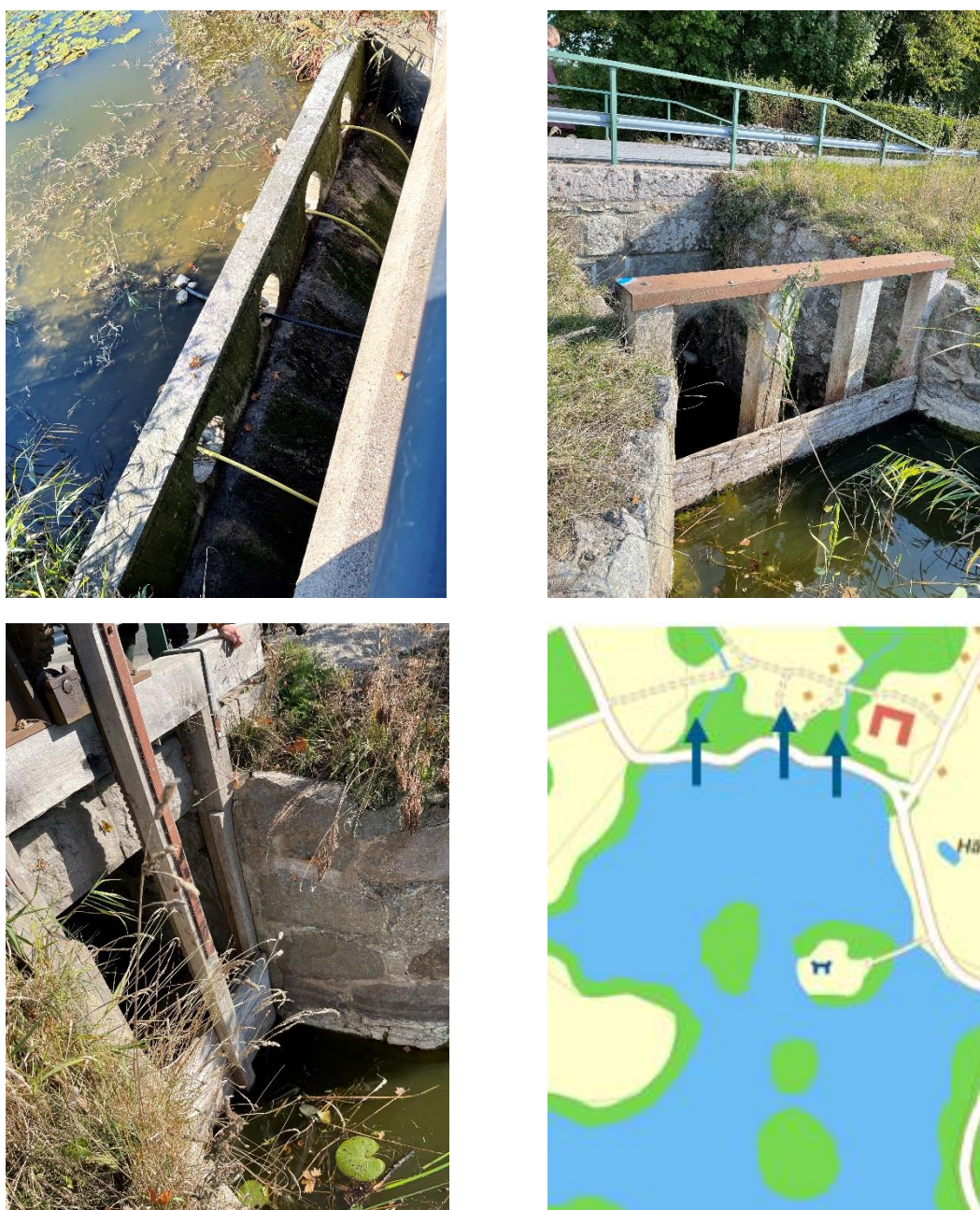
Figur 4 De olika strukturerna vid Häckebergas utlopp. Övre vänstra: Huvudutloppet som är beläget i väst är det utskov med störst flödespotential. Övre högra: Mittenutloppet, som är ett fast dämme. Nedre vänstra: Reglerbar lucka som idag är det enda utloppet som regleras aktivt. Nedre högra: Placering av de tre utloppen (karta från Eniro.se).
