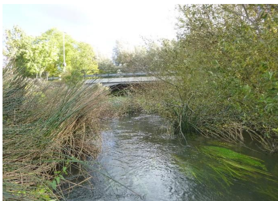
20-30 m nedströms bro
