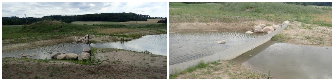
Bild 44. T.v. Uppströms meandersträckan (inloppet) finns ytterligare ett dämme för en mindre damm i systemets start, detta har ett hål för lågvattenföring samt kan däckas ytterligare vid höglöden; T.h. Översta dämmet i metall, förstärkt med stensättning.
