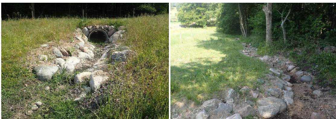
Bild 69. T.v. Det öppna utløppet leder genom en trumma för körbarhet på vällen till höger och sedan ut till ytterligare stensatt sektion i ett skogsdike som leder vidare som en bäck; T.h. Utløppets fortsatta väg som blir bäckfåran när det öppna utløppet är vattenförande.
