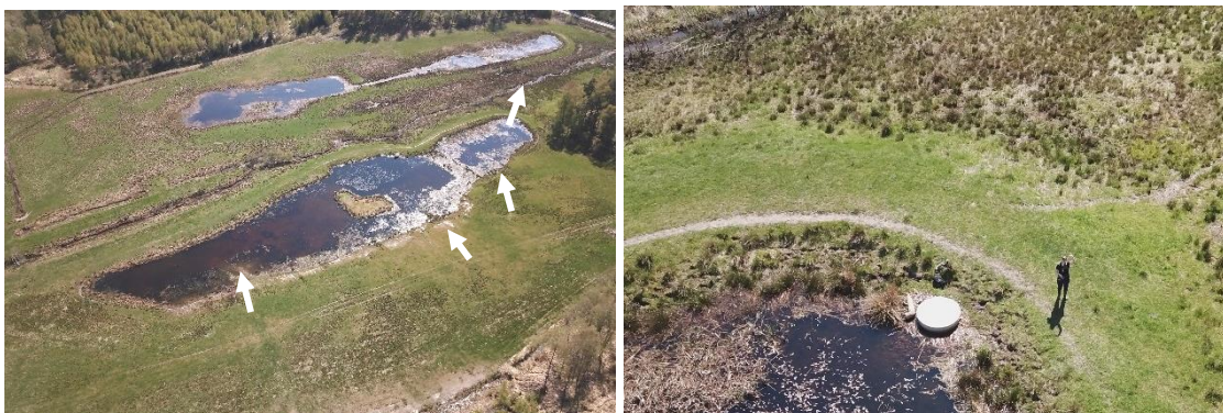
Bild 80. T.v. Översikt våtmark med pilar som markerar in- och utlopp; T.h. Nivåbrunn och intilliggande säkerhetsrör. En kombination med ett öppet stensatt utlopp hade varit en möjlighet vid anläggning.
