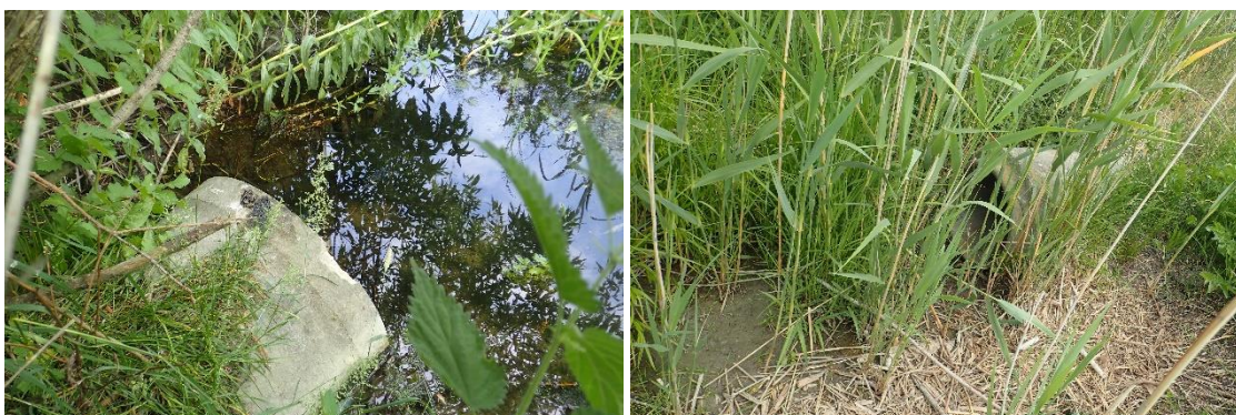
Bild 6. T.v. Betong kulvert som leder från brunnen till diket, står vatten in från diket, svårt att bedöma utflöde; T.h. Huvudsakligt inlopp leder vatten in från dike, är vid besöket dock torrt.
