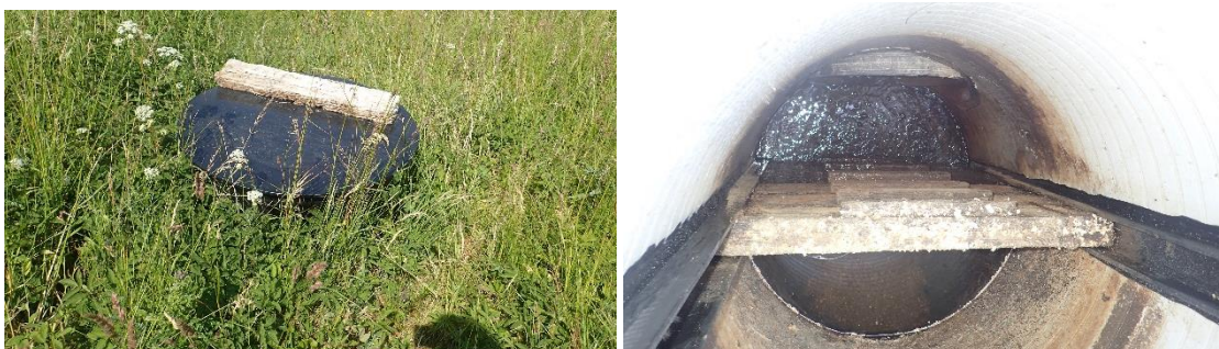
Bild 13. T.v. Utloppsbrunnen (munk) med gummilock; T.h. Munkens plankläggning med lister för förenklad skötsel med t.ex. kratta för att flytta plankor dock djup brunn. Visst läckage noterat, ca 40cm upp till utsatt VG, håller dock troligt vatten vid högflöden.
