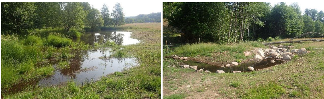
Bild 74. T.v. Första delen av det nedre våtmarksområdet; T.h. Sista tröskeln som också är stensatt samt en meanderslinga med tilltagande fall bakom, på halvön finns en nivåbrunn med möjlighet att sänka av området vid höga flöden.
