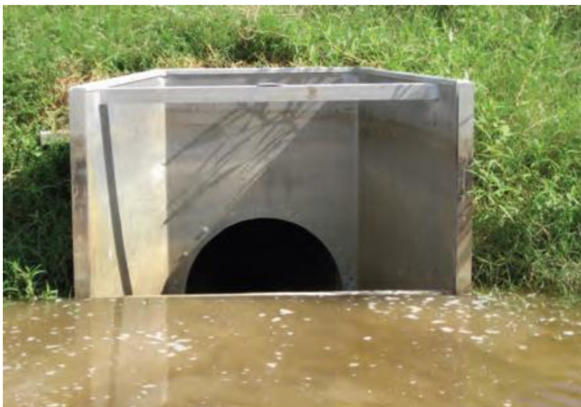
Bild 8. Ett munksystem där ytvatten tas in i utloppsbrunnen, överst en schematisk skiss och nederst ett fotografi på en sådan lösning. Från Locke et al. (2017).
