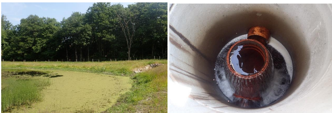
Bild 24. T.v. Kombinerat utlopp med öppet utlopp till höger i bild samt en nivåbrunn för möjlighet att reglera systemet; t.h. nivåbrunn med flöde genom nivåröret, (D3)
