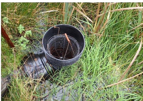
Bild 96. T.v. Säkerhetsrör med böj och hemmabyggt skyddsanordning i form av en korg; T.h. Snabelröret som precis vinklats ner för att sänka vattennivån.
