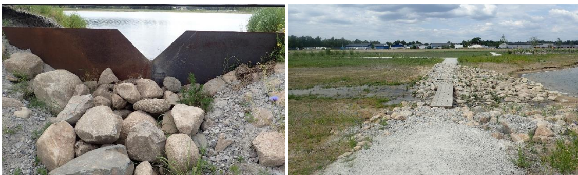
Bild 33. T.v. Järnsponsdämma med ett V-överfall och skyddande stensättning, samma konstruktion på båda utloppen; T.h. Öppet stensatt inlopp från en grund meandersträcka.
