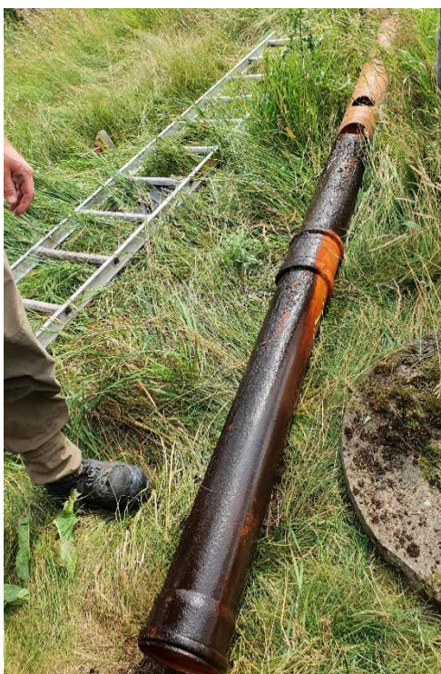
Bild 78. T.v. Brunnen när våtmarken tömts och nivåröret är utdraget, både säkerhetsrör och bottenrör leder till brunnen; T.h. Tömd brunn med isatt nivårör.
