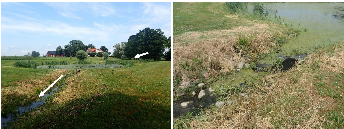
Bild 38. T.v. Översikt från utloppets öppna dike som leder ned mot recipienten (bäck/dike); T.h. Mindre gummidämme samt stensatt, inga tecken på erosion eller negativ påverkan.
