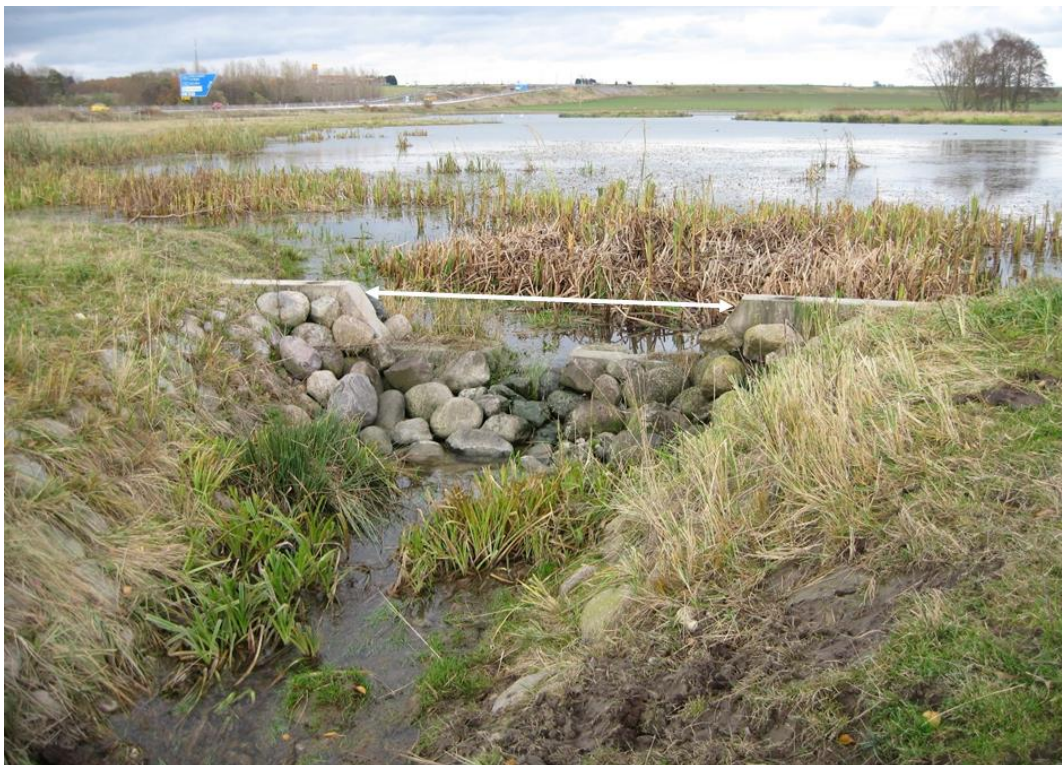
Bild 2. Öppet utlopp från en stor, grund våtmark utanför Röstånga, Skåne. Stensatt betongfundament med överfall, utskovet markerat med vit pil. Foto: HS Halland, arkivbild.
