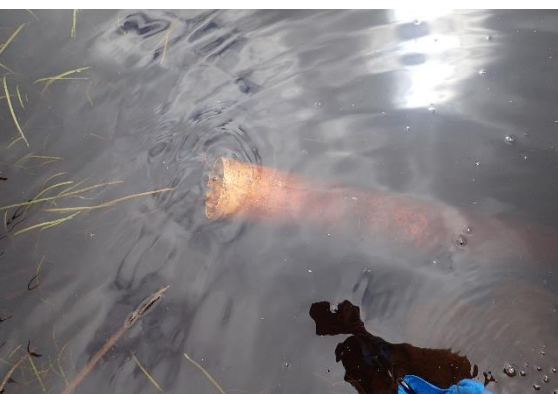
Bild 96. T.v. Säkerhetsrör med böj och hemmabyggt skyddsanordning i form av en korg; T.h. Snabelröret som precis vinklats ner för att sänka vattennivån.
