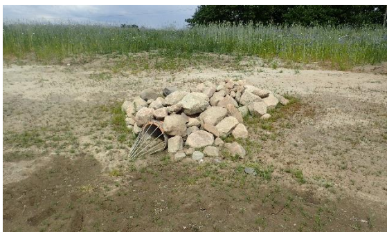
Bild 31. T.v. Bottenröret är skyddat av ett metallgaller som är konformat för att minska risken för att det blockeras av växtlighet; T.h. En stensatt bräddning över vall och gångväg till närliggande dike.
