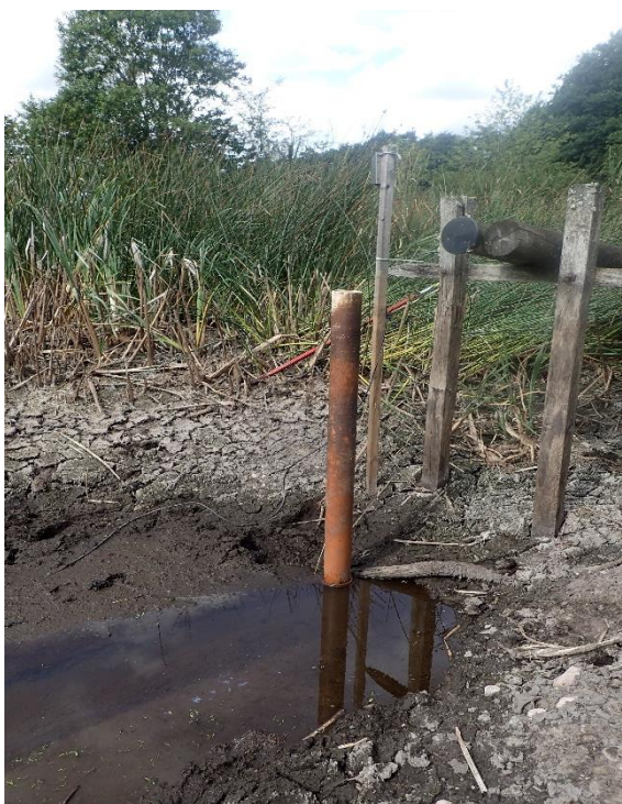
Bild 96. T.v. Säkerhetsrör med böj och hemmabyggt skyddsanordning i form av en korg; T.h. Snabelröret som precis vinklats ner för att sänka vattennivån.
