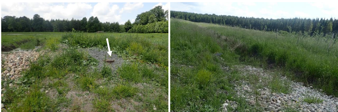
Bild 67. T.v. Mindre brunn till vänster om dämnet, inget flöde in eller ut, ca 10cm till VG för inkommande rör vid position i våtmarken; T.h. Mottagande skogsdike.
