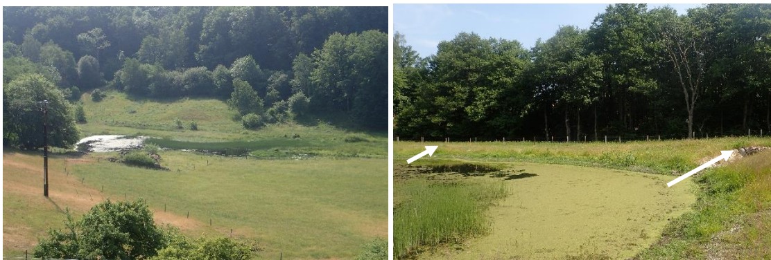
Bild 68. T.v. Översikt över våtmarken som 2022 restaurerats och fått nytt utløppssystem. Ett vattendrag/bäck leds genom systemet därav vikten av ett öppet utløpp; T.h. Nivå-brunn till vänster och öppet stensatt utløpp.
