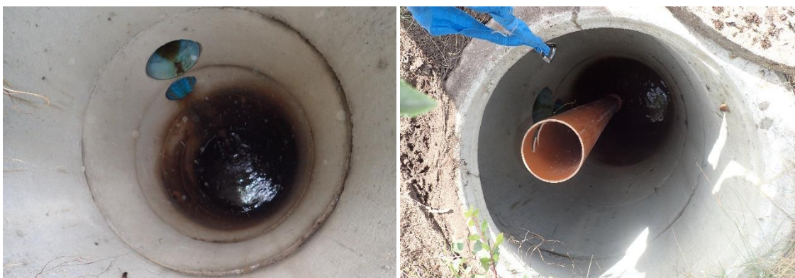
Bild 78. T.v. Brunnen när våtmarken tömts och nivåröret är utdraget, både säkerhetsrör och bottenrör leder till brunnen; T.h. Tömd brunn med isatt nivårör.
