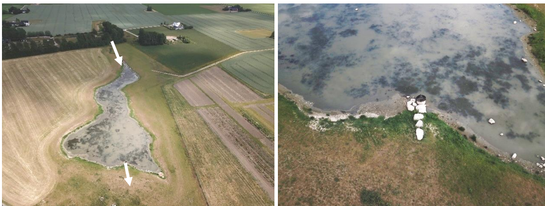
Bild 23. T.v. Översiktsbild av våtmarken med utloppet i botten; T.h. Störtbrunn med lagda stenar som underlättar åtkomst vid framförallt lågflöden.
