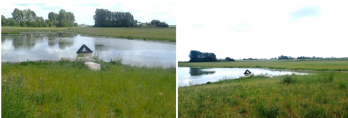
Bild 25. Överfallsbrunn och stenläggning.
