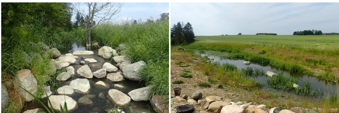
Bild 58. T.v. Tröskeln har klarat höstens höglöden väl och ingen större erosion noterades vid besöket; T.h. En våtmark med kapacitet att ta emot vattendragets nivåvariationer.
