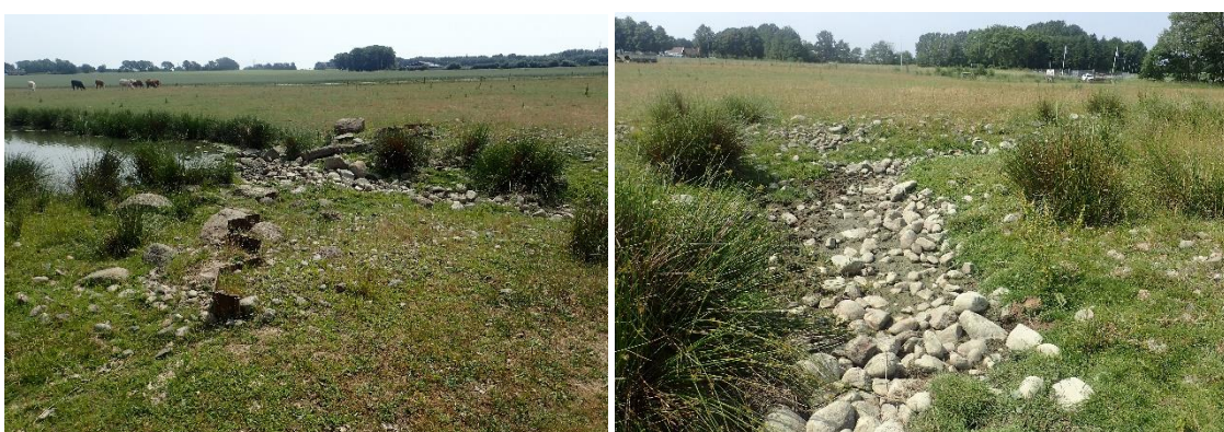
Bild 48. T.v. Järnsponsen från annan vinkel, inga tecken på erosionsskador; T.h. En öppen stensatt bäcksträcka leder från utløppet ca 60m tills flödet leds ner i en kulvert. Trots tramp från betesdjur har sträckan behållit sin funktion väl.
