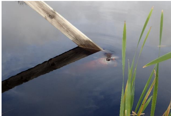
Bild 93. T.v. Översikt från utloppssidan; T.h. Snabeln är fäst med en plank för att från en brygga underlätta vinkling.
