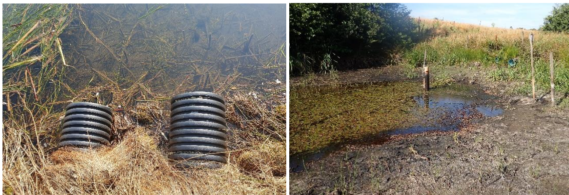
Bild 92. T.v. Våtmarkens dubbla sikkerhetsrør som tar vatten ved kraftige hoggløden som snabeln ej er dimensionert for; T.h. Snabeln og sikkerhetsrøren syns i bild efter att våtmarken sänkt och snabel nu riktats tillbaka till max-nivå.
