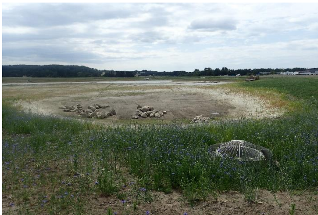
Bild 29. T.v. Översikt från våtmarkens övre delar som vid besöket var delvis vattenfyllda; T.h. Utløpsdelen var vid besöket torr, i förgrunden syns störtbrunnen och i stenarna ligger även ett bottenrör.
