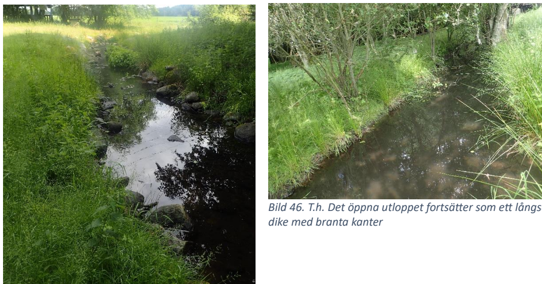
Bild 45. T.v. Vid sidan av våtmarken löper ett vattendrag som tidigare dämtes, detta har nu stensatts och blivit en fin strömsträcka.
