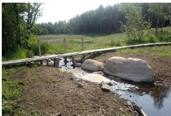
Bild 72. T.v. Välanlagd stenströskel med spång för friluftslivet i området; T.h. Viss "problematik" med potentiellt dämmande växtlighet precis nedströms stenströskeln. Kommentarer från konulten: Samtliga stenströsklar som anlagts har fått stor breddningskapacitet förskjutet mot fastare mark. "Värt att notera att de två uppströms områdena har designats med hänsyn till den rika växtligheten. Denna har faktiskt en avgörande funktion för såväl hydraulik som miljöeffekter. I praktiken så har en återmeandering i kombination med högre basnivå hyperaktiverat svämplanet som till del kan liknas vid ett kärr."
