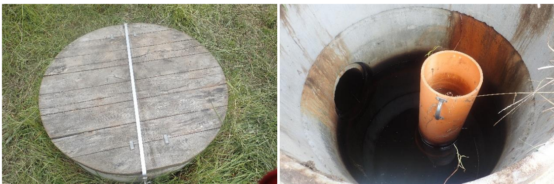
Bild 61. T.v. Nivåbrunn med lätt och smidigt trälock med låsanordning; T.h. Nivåröret är lätt att nå samt har ett påmonterat handtag för förenklad hantering.
