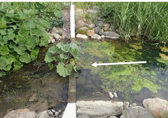
Bild 36. T.v. Annan vinkel som visar igenväxning kring utloppet; T.h. Det nya betongdämnet har placerats framför det gamla suldämnet och stabiliserats med natursten, inga tecken på erosion sedan restaurering.
