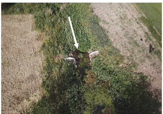
Bild 36. T.v. Annan vinkel som visar igenväxning kring utloppet; T.h. Det nya betongdämnet har placerats framför det gamla suldämnet och stabiliserats med natursten, inga tecken på erosion sedan restaurering.
