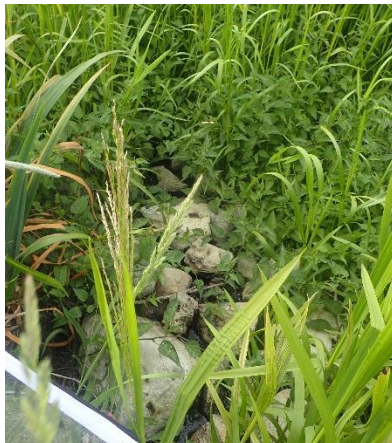
Bild 43. T.v. Lera dominerar i utloppet uppe på körsträckan på vallen, dock körbart; T.h. Stensättningen syns tydligt i det brantare fallet ner mot recipienten (dike), inte fiskförande under lågflöden.
