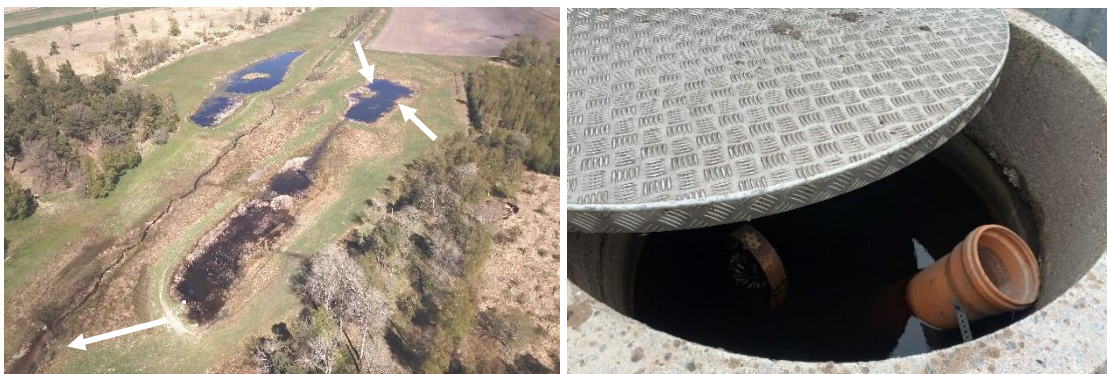
Bild 83. T.v. Översiktsbild på våtmarken till höger, in- och utlopp markerade med pilar; T.h. Nivåbrunn med två olika rör beroende på nivå, ett sitter i det andra flyter löst i brunnen.
