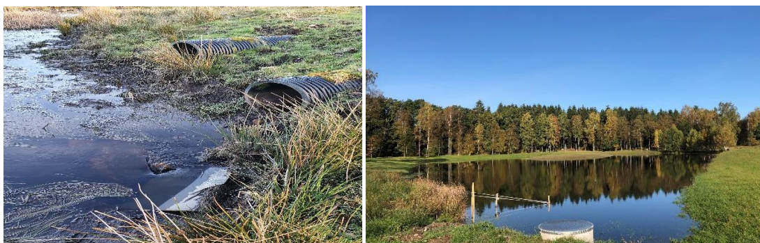
Bild 88. T.v. Nivåbrunnen kombineras med två säkerhetsrör i plast för att skydda vallen vid höglöden, delvis är rörsättningen något påverkad av tramp från betesdjur; T.h. Översiktsild från utloppet.
