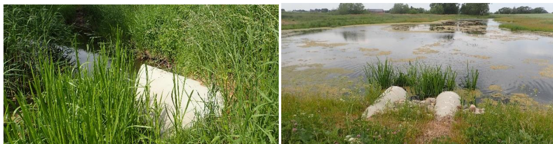
Bild 28. T.v. Stor betongtrumma i sektioner (se bild 2 t.v.) leder genom vallen (körbar) till recipienten (bäck); T.h. Inlopp från kopplad våtmark uppströms.
