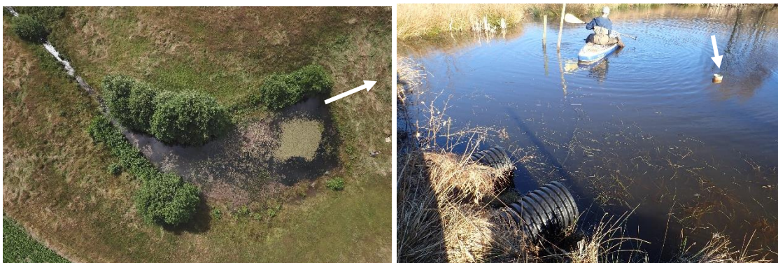
Bild 91. T.v. Oversikt med in- og utløpp markerte; T.h. Till høger i bild syns snabelrøret sticka upp ur vattenspegeln.
