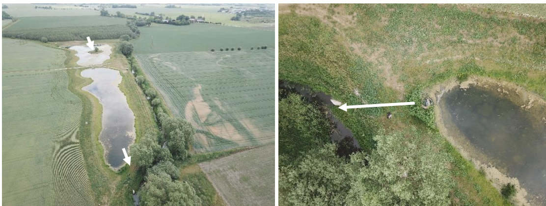
Bild 26. T.v. Översiktsbild med pil för ritningen av rör från störtbrunnen under den körbara vallen, kopplad våtmark uppströms; T.h. Störtbrunn och våtmark till höger, recipient (vattendrag) till vänster.
