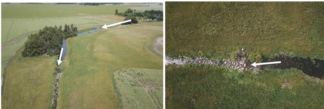
Bild 56. T.v. Översikt över våtmarken som är en smal utvidgning/dämning av ett dike/vattendrag; T.h. Den stensatta tröskeln.
