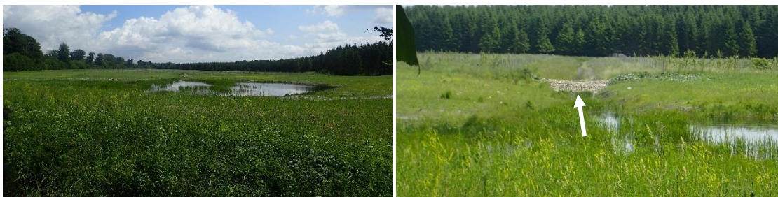
Bild 65. T.v. Översikt över våtmarken som är ett fördröjningsmagasin med stensatt fördämning i befintligt dike samt grävt ur våtmarksområdet. Vid besöket noterades inget inflöde och endast lite vatten i våtmarken; T.h. Det stensatta dämnet med diket i bakgrunden.
