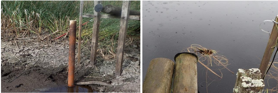
Bild 27. T.v. Snabelrör i en tömd våtmark (F4); T.h. Snabelrör i en full våtmark, illustrerar även problematiken kring flytande vegetation som sätter igen snabeln (F4).
