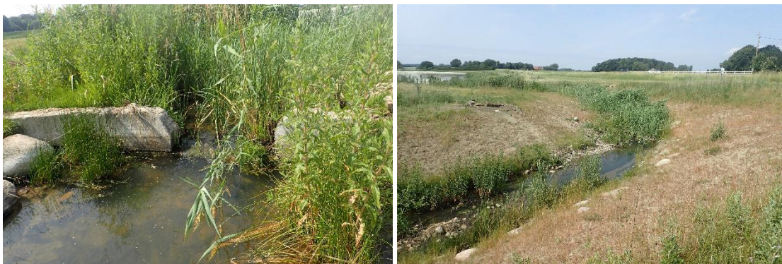
Bild 19. T.v. En betongtröskel där vegetation och sediment etablerat sig vilket riskerar att vattnet tar andra vägar vid höglöde och eroderar kanterna (C6); T.h. Betongdämnet leder till en öppen stensatt strömsträcka som utan skötsel växer igen men som för dagen fungerar väl och tillför viktiga mikrohabitat i vattendraget.
