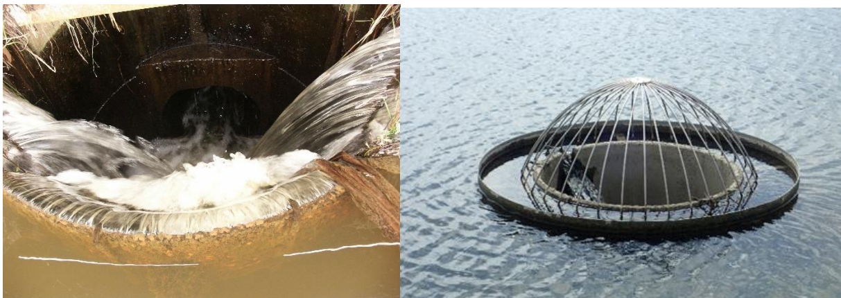
Bild 10. Till vänster: överfallsbrunn/störtbrunn utan galler/sil. Foto: HS Halland arkivbild. Till höger: med galler (foto Sofia Hedman)
