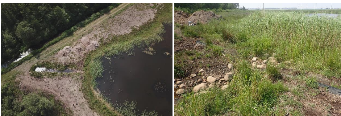
Bild 22. T.v. drönarfoto på öppet utlopp som leder till trumma under körväg och vidare till vattendrag, ej vandringsbart vid besöket men troligtvis under stora delar av året; t.h. dämnet består av två stycken nedgrävda gummidämmen som dock påverkas av igenväxning, tramp från betesdjur samt erosion när vattnet tagit andra vägar vid högvatten (C7).
