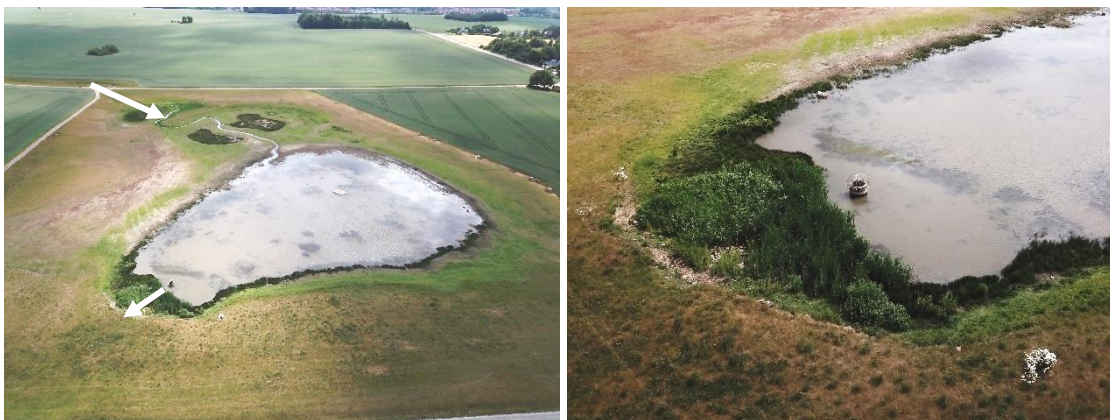
Bild 21. T.v. Översiktsbild av våtmarken med utloppet i kanten på bilden; T.h. Störtbrunn och viss igenväxning påbörjad vid utloppsområdet.
