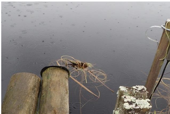
Bild 95. T.v. Översiktsbild med våtmarkens in- och utlopp markerat; T.h. Snabelrör i max-nivå, exempel på hur växtlighet fastnar runt snabeln.
