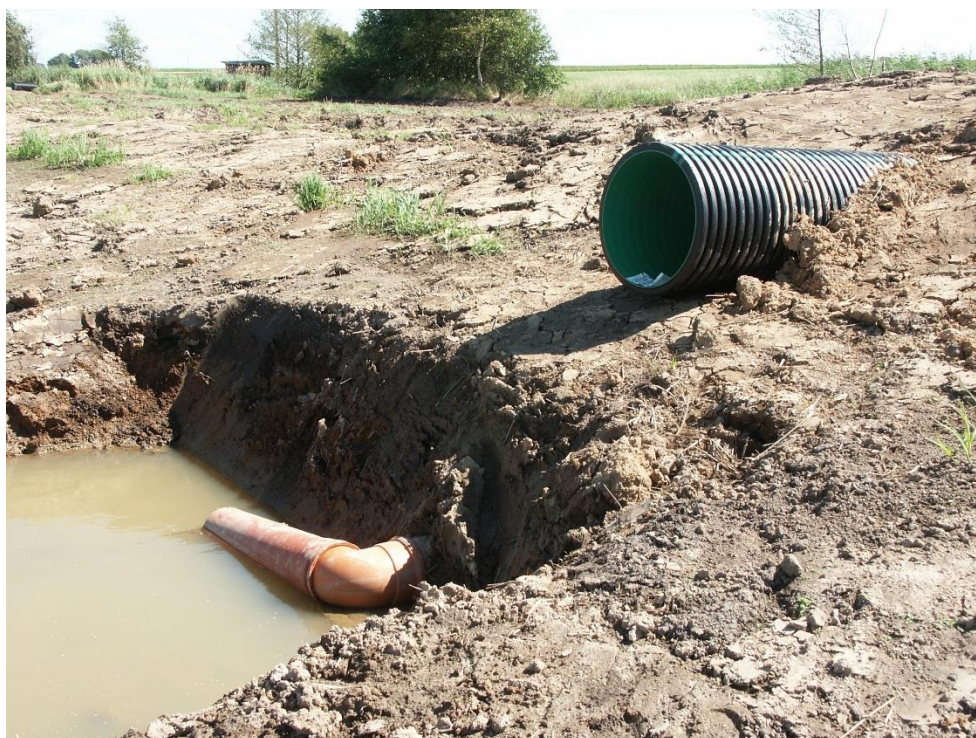
Bild 3. Utlopp med vridbart rör placerad i brunn efter våtmarken (Tousignant m.fl. 1999).
