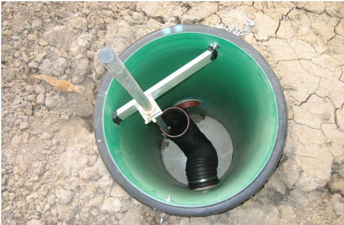
Bild 7. En minimunk med reglerbar slang. Foto HS Halland, arkivbild.
