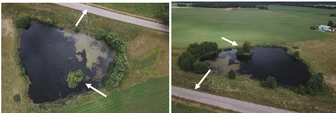
Bild 77. Översiktspild av våtmarken med pilar för in och utlopp, bottenrör till nivåbrunn som leder vidare i kulvert under vägen.
