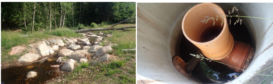
Bild 75. T.v. Brunnen syns något i gräset på halvön, och trösklen skapar en kortare strömsträcka innan vattendraget går vidare i dalgången; T.h. Nivårör i brunnen för möjlig till sänkning, saknar handtag men är lätt att nå, stiga-rör med inloppsvatten, inga tecken på läckage.
