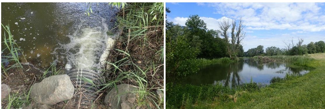
Bild 17. T.v. Ingen erosion eller negativ påverkan noterad på röret som leder från brunn till recipient; T.h. Mycket groddjur, vid besöket framförallt ätlig groda (Rana edulis) vilket motiverar valet av ett icke vandringsbart utlopp.
