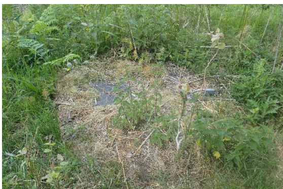
Bild 8. T.v. Utloppsbrunnen (munk) med gummilock och lås, ser ej skött ut på flertalet år; T.h. Recipienten är ett vattenfylld skogsdike, ej möjligt att konstatera utflöde.
