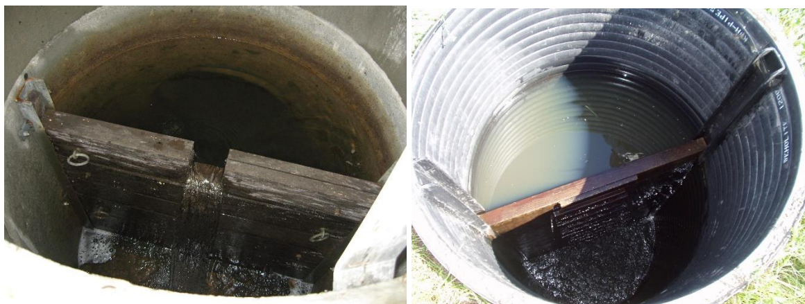
Bild 6. Till vänster: en munk av betongringstyp med plankor som styr vattennivån. I översta plankan har ett mindre utfall sågats. Till höger: en munk i plast med plankor där regler fästs för enklare hantering. Foton HS Halland arkivbilder.
