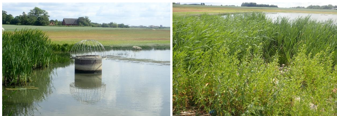
Bild 22. T.v. Svåråtkomlig störtbrunn, troligt utan utflöde vid besöket1, T.h. Vassområde som börjar etablera sig i utloppsområdet.
