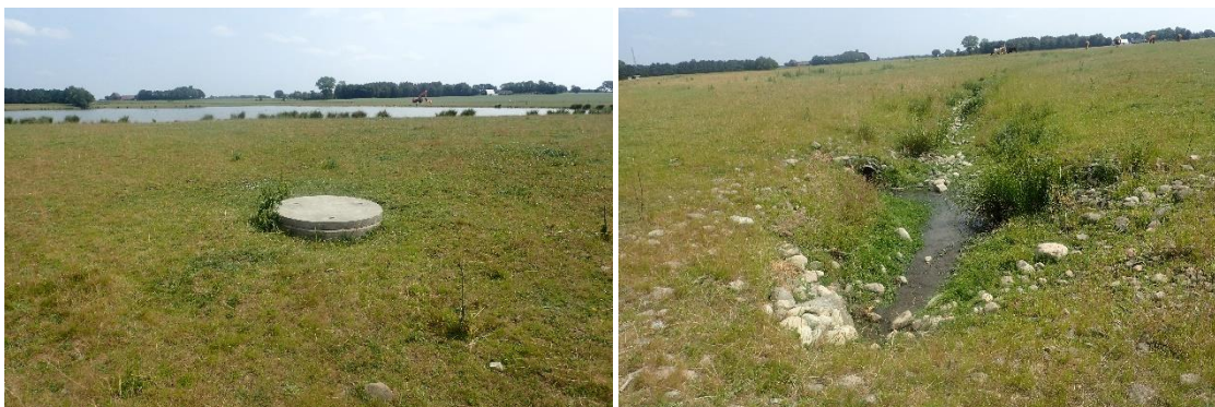
Bild 49. T.v. En brunn noteres ved våtmarken, det rinner i denna og sannolikt ligger ett bottenrör i våtmarken som för dagen fungerer som huvudsakligt utløpp; T.h. Vatten, troligen från brunnen, kommer ut på samme plats som det öppna stensatta diket.
