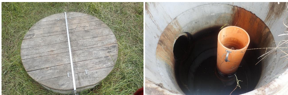
Bild 23. T.v. Nivåbrunn med lätt och smidigt trälock med låsanordning; T.h. Nivåröret är lätt att nå samt har ett påmonterat handtag för förenklad hantering (D1).
