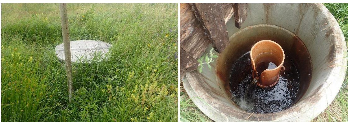
Bild 63. T.v. Nivåbrunn med lätt och smidigt trälock med låsanordning; T.h. Nivåröret är lätt att nå samt har ett påmonterat handtag för förenklad hantering, markägaren har anpassat nivån genom att såga ett V i röret.
