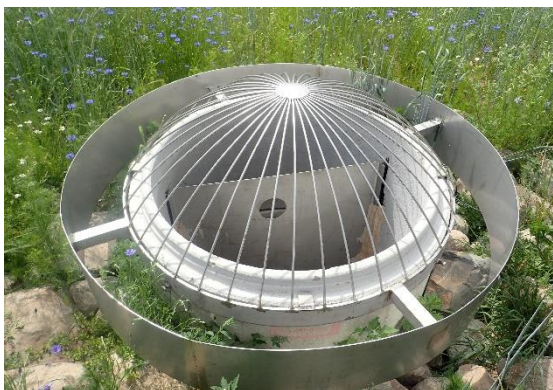
Bild 30. T.v. Störtbrunn med krage som skyddar mot flytande vegetation; T.h. Tack vare bottenröret som leds in i brunnen samt dess metallskiva skulle brunnen även kunna fungera som en reglerbrunn, dock noteras att metallskivan ser fast tätad ut och ej reglerbar i dagsläget.
