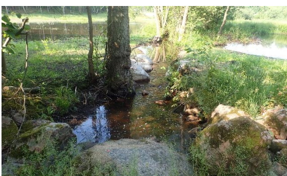
Bild 73. T.v. Andra våtmarksområdet; T.h. Andra stensatta tröskeln, här går vattnet under några större stenar vid lågflöde, och troligtvis över vid högre flöden
