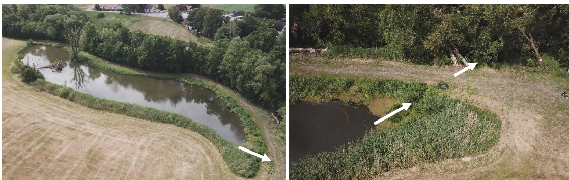
Bild 15. T.v. Översiktsbild med utloppet höger i bild; T.h. Utloppsbrunnen (munk) med bottenrör i våtmarken som sedan leder ut till närliggande vattendrag, viss igenväxning påbörjad i området kring utloppet, påverkan på bottenrör beror på dess placering ut i dammen.
