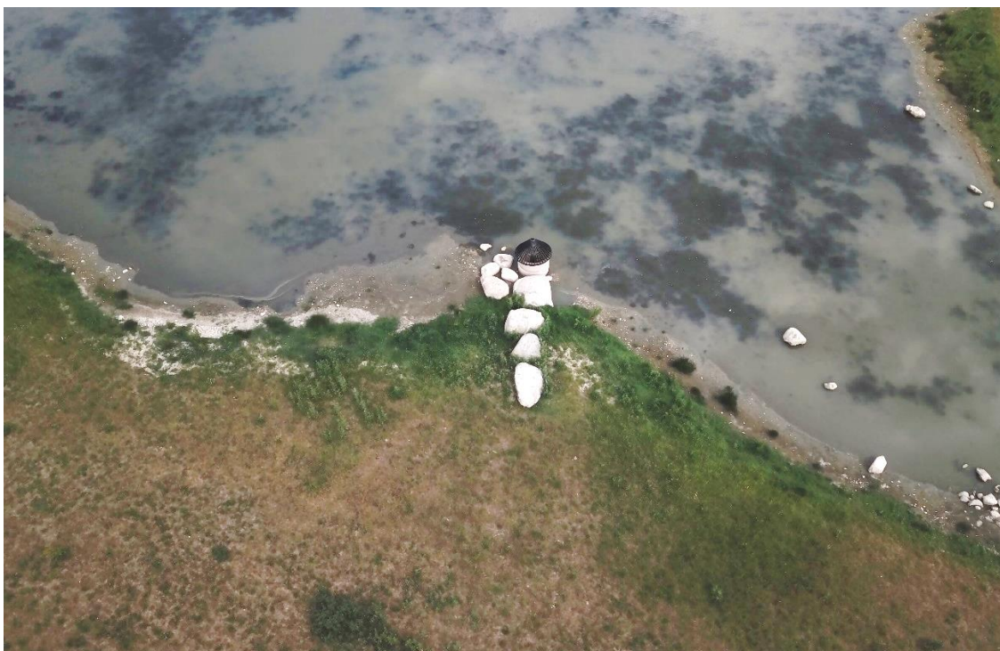
Bild 17. Våtmark B3, här når man störtbrunnen vid lågflöden, och tack vare stensättning även vid högre vattennivåer.
