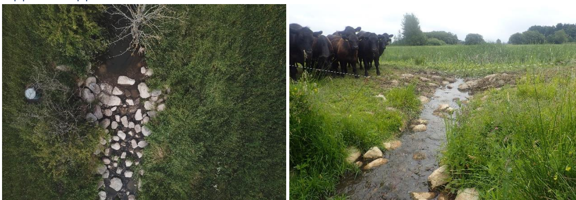
Bild 18. T.v. Ett nyanlagt stensatt öppet utlopp i en våtmark i ett vattendrag(C8); T.h. Ett stensatt utlopp mellan två våtmarker som i detta fall är körbart och klarar trampet från djur väl (D1).
