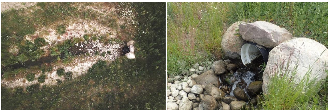
Bild 20. T.v. Öppna diket där utloppet mynnar från våtmarksvallen och leder vidare ner till recipienten (bäck); T.h. Ordentligt stensatt kring utloppsroret för att minska risken för erosion och rörelse.
