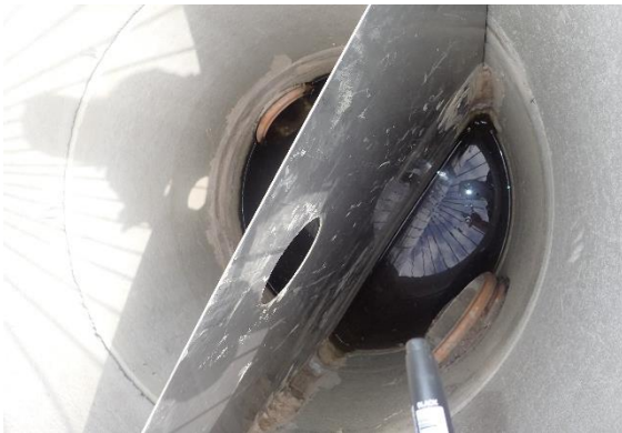
Bild 30. T.v. Störtbrunn med krage som skyddar mot flytande vegetation; T.h. Tack vare bottenröret som leds in i brunnen samt dess metallskiva skulle brunnen även kunna fungera som en reglerbrunn, dock noteras att metallskivan ser fast tätad ut och ej reglerbar i dagsläget.
