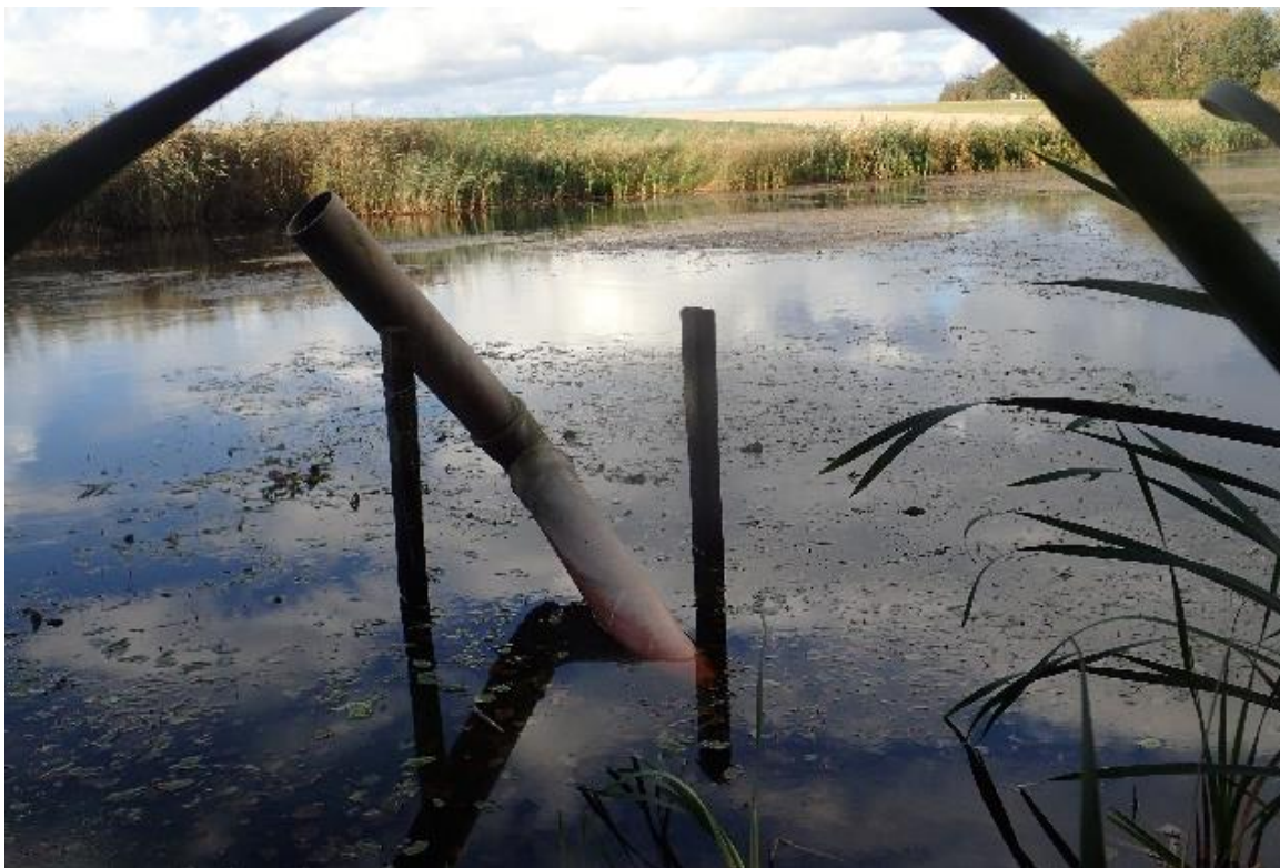
Bild 28. F1, exempel där snabelröret lyfts när det fyllts av luft och våtmarksvallen riskerar att svämmas av de nya nivåerna.
