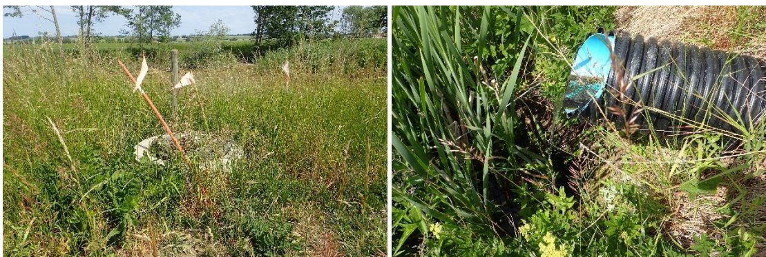
Bild 2. T.v. Utloppsbrunnen med betonglock; T.h. Vid besöket rinner vatten ut från våtmarken till recipienten.
