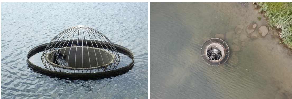
Bild 19. T.v. Störtbrunn med skyddande metallring och öppning för lågvattenföring; T.h. Störtbrunn ovanifrån, vid lågvatten troligt nåbar med stövlar.
