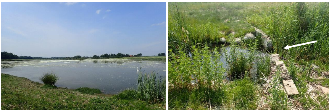
Bild 50. T.v. Översiktssbild över våtmarken, öppen våtmark med mycket rastande fågel; T.h. Det öppna utloppet med betongtröskel, problematik med igenväxning framför och efter dämnet finns.
