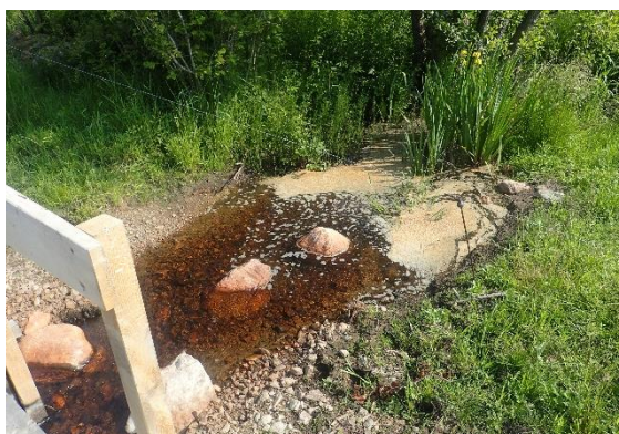
Bild 72. T.v. Välanlagd stenströskel med spång för friluftslivet i området; T.h. Viss "problematik" med potentiellt dämmande växtlighet precis nedströms stenströskeln. Kommentarer från konulten: Samtliga stenströsklar som anlagts har fått stor breddningskapacitet förskjutet mot fastare mark. "Värt att notera att de två uppströms områdena har designats med hänsyn till den rika växtligheten. Denna har faktiskt en avgörande funktion för såväl hydraulik som miljöeffekter. I praktiken så har en återmeandering i kombination med högre basnivå hyperaktiverat svämplanet som till del kan liknas vid ett kärr."
