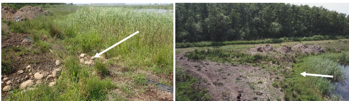
Bild 54. T.v. Gummidämme och stensättning, för dagen sker inget flöde i utloppet och det är påverkat av både igenväxning och sedimentation samt tramp och erosion till följd av betesdjur; T.h. Till höger i bild ses vassområdet som etablerats framför utloppet. Jordhögar i anslutning indikerar att viss bortförsel av växtlighet har skett kring utloppet och våtmarken.
