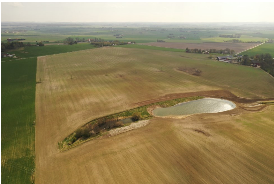
Dammkomplex anlagt år 1999 som under året har rensats och ena dammens yta har sjudubblats.
