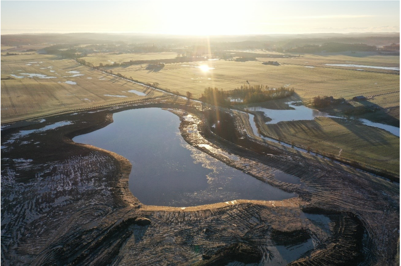
Bild 7. Bilden visar en drönarbild av Björnstorps bevattningsvåtmark som anlades vintern 2023.
