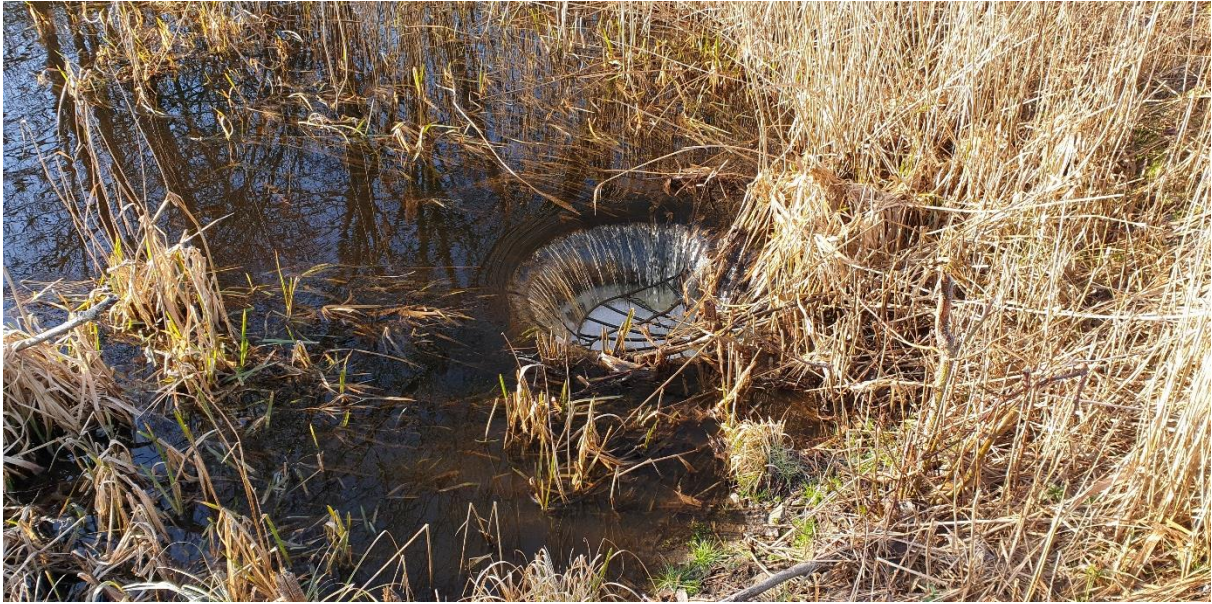
Figur 3 Utloppsbrunnen i damm H37 före åtgärd, 2020-02-27
