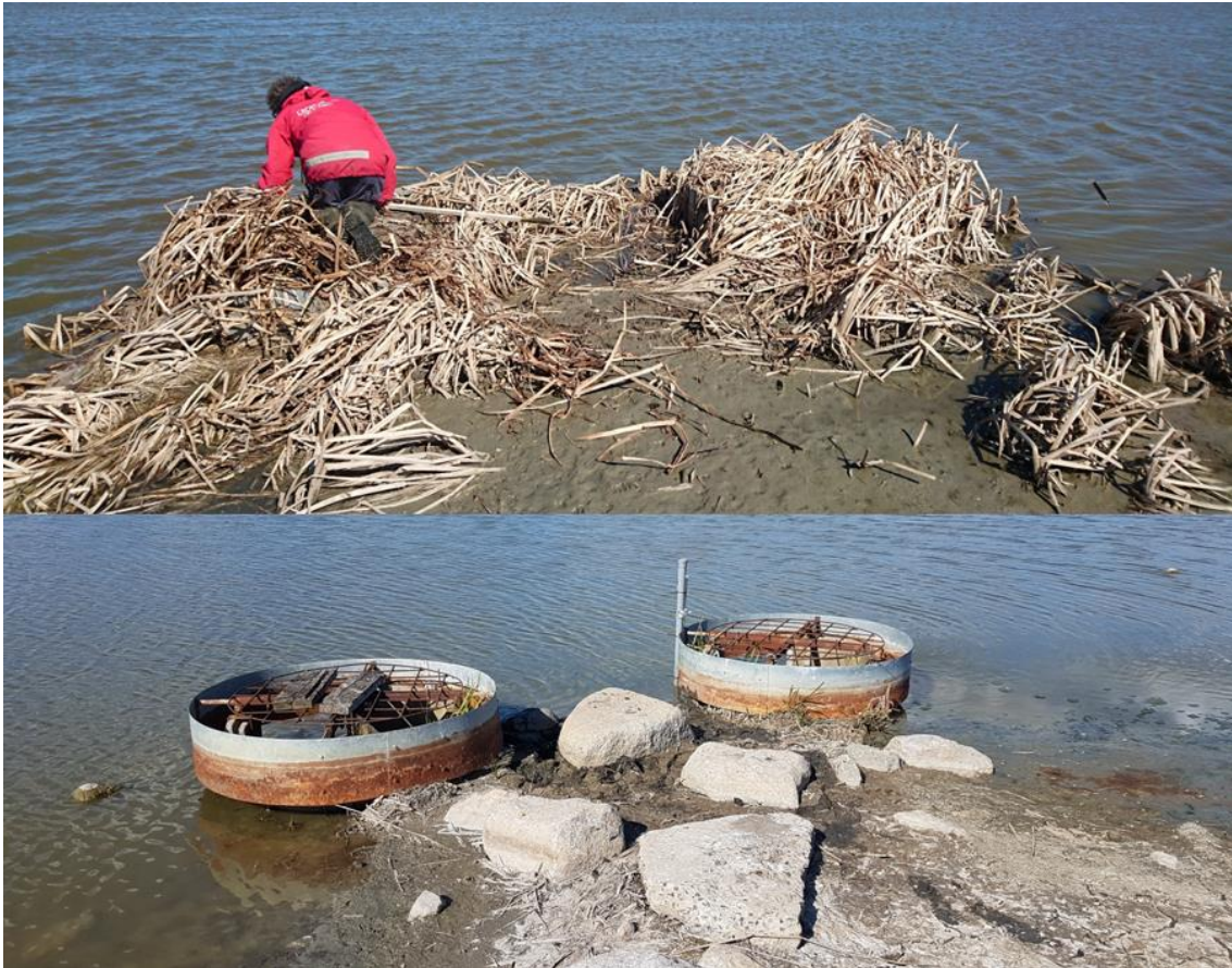
Figur 28 Utloppsbrunnarna i H50 före (övre bilden) och efter (nedre bilden) åtgärd.
