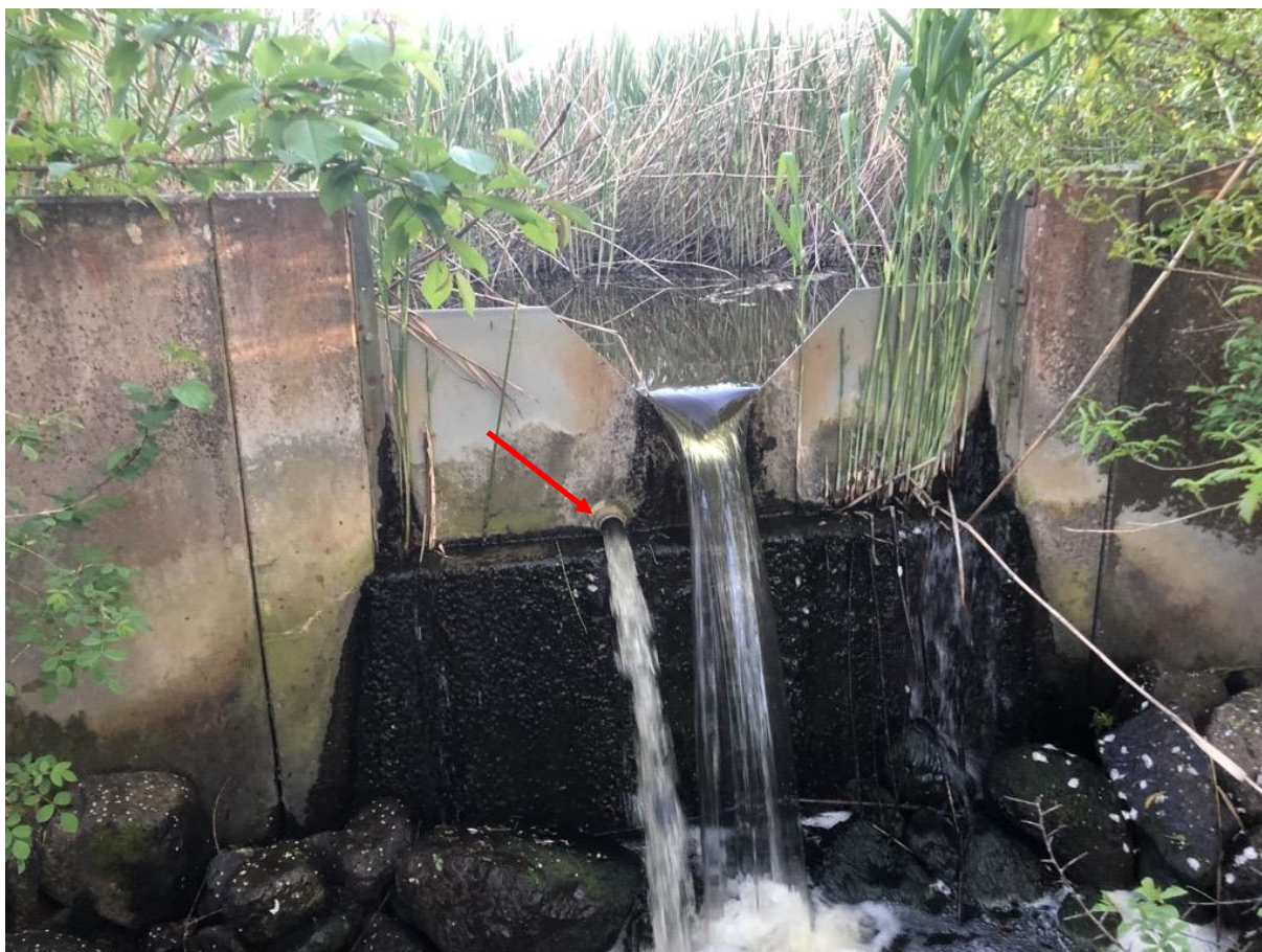
Figur 7 Utloppet från damm H38 efter åtgärd, 2024-05-13. Hål/rör för minitappning monterat i nedre delen av plåten.
