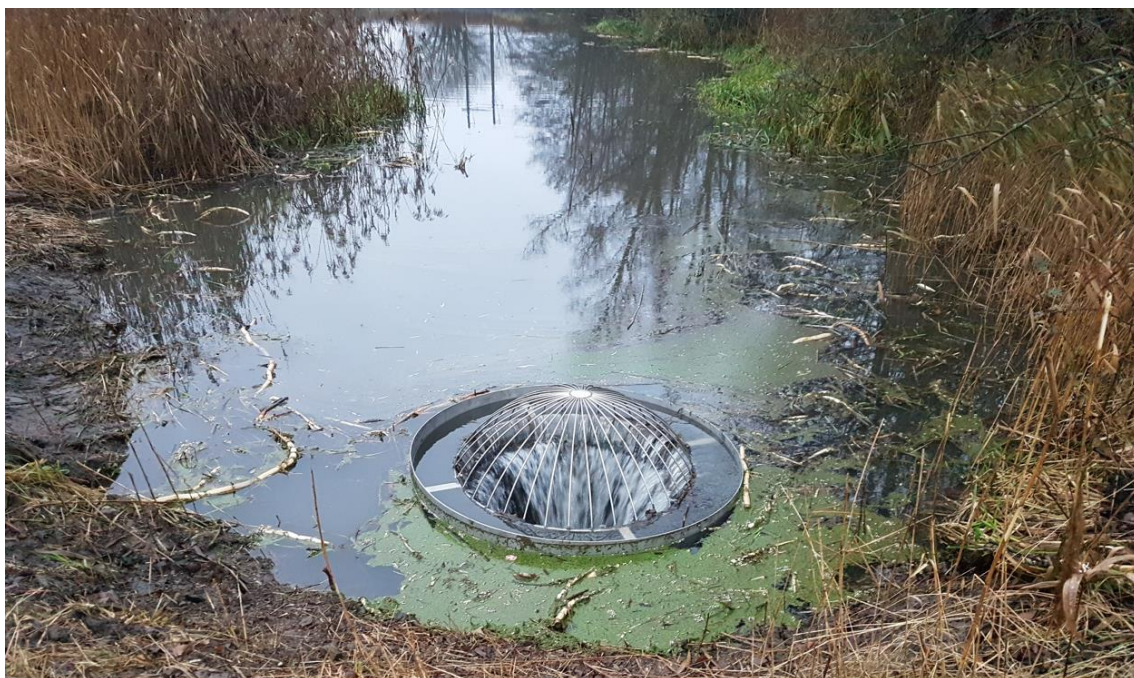
Figur 25 Utloppsbrunnen i H37 efter åtgärd. Vattenföringen i Trolleberg var denna dag (2022-12-05) 1,1 \text{ m}^3/\text{s} , vilket ungefär motsvarar hälften av medelvattenföringen.
