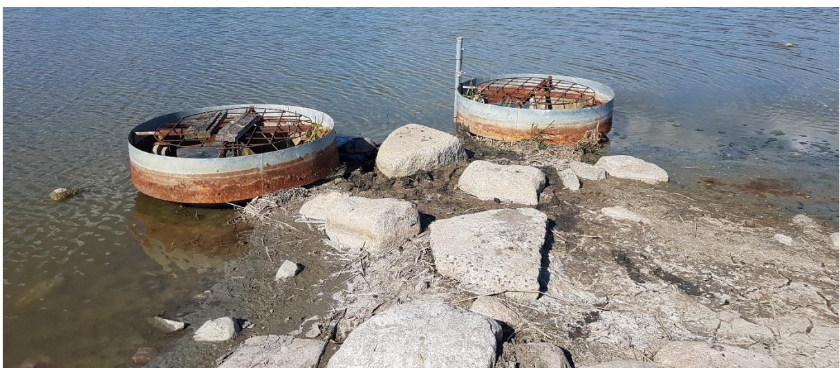
Figur 10 Utloppsbrunnar efter åtgärd, 2023-05-03.
